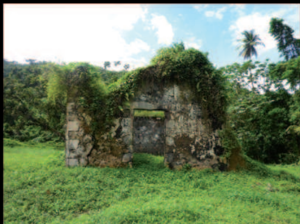
Vestige de la maison principale avant travaux (Porte d'entrée)
