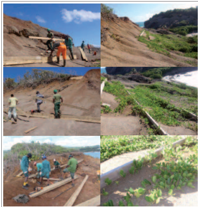
Restauration de la végétation.
