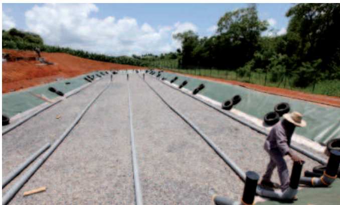
Pose de la géomembrane pour assurer l'étanchéité du système
