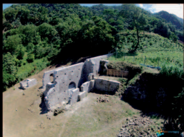
Vestige du bâtiment à roue et du mur de soutènement pendant les travaux
