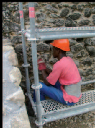
ALY Vivien, volontaire service civique, piquage des anciens enduits de la sucrerie
