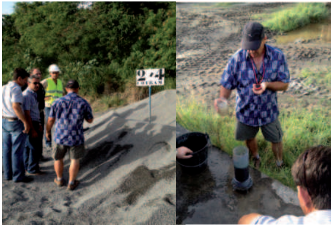
Contrôle de la qualité des matériaux par les Tests de Percolation
