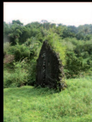
Pignon de la sucrerie (Façade Sud)
