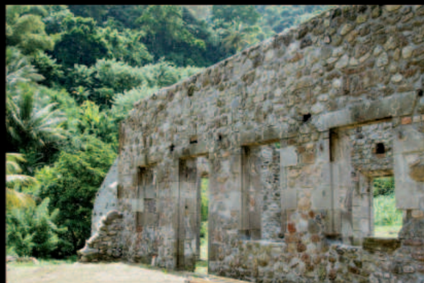
Vestige de la maison principale après travaux (Façade Sud)
