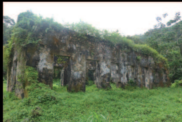
Vestige de la maison principale avant travaux (Façade Sud)
