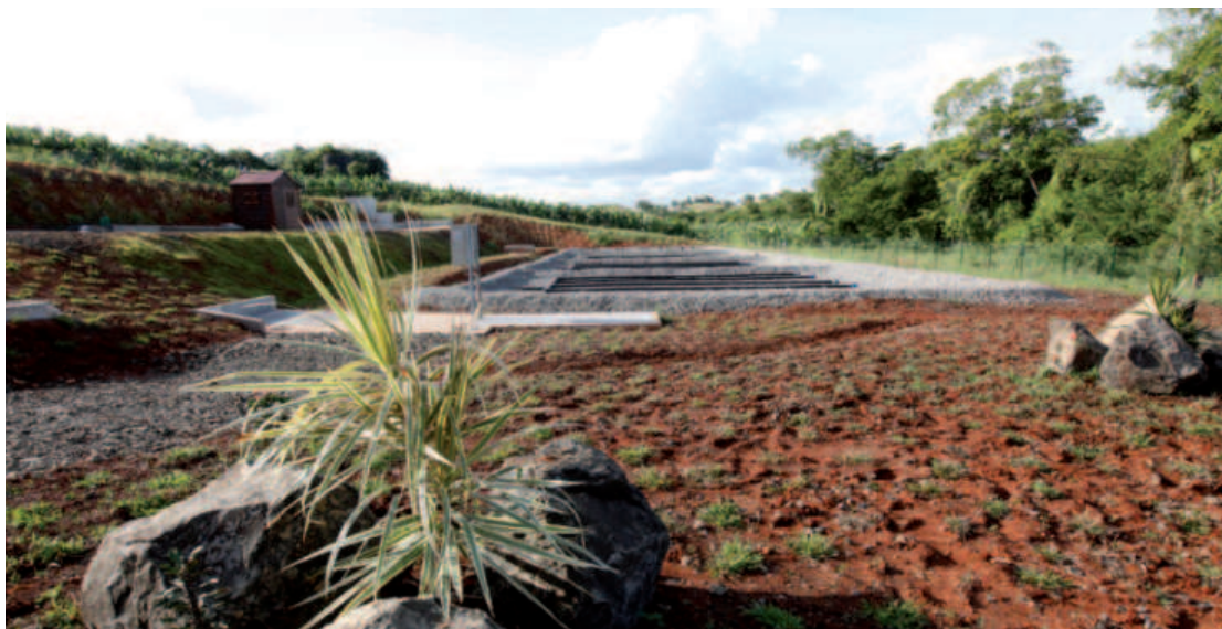
La capacité de la station est de 1 360 Équivalent Habitants (EH)
