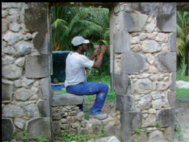
Marie-Sainte Eddy, volontaire service civique taille des jambages de fenêtres
