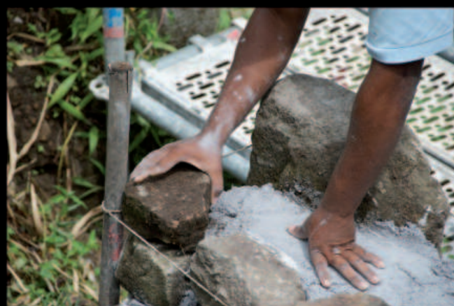
Maçonnage d'une pierre d'angle du mur de soutènement
