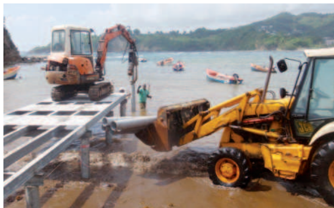
La construction du ponton, une première pour l'ONF et ses équipes.
