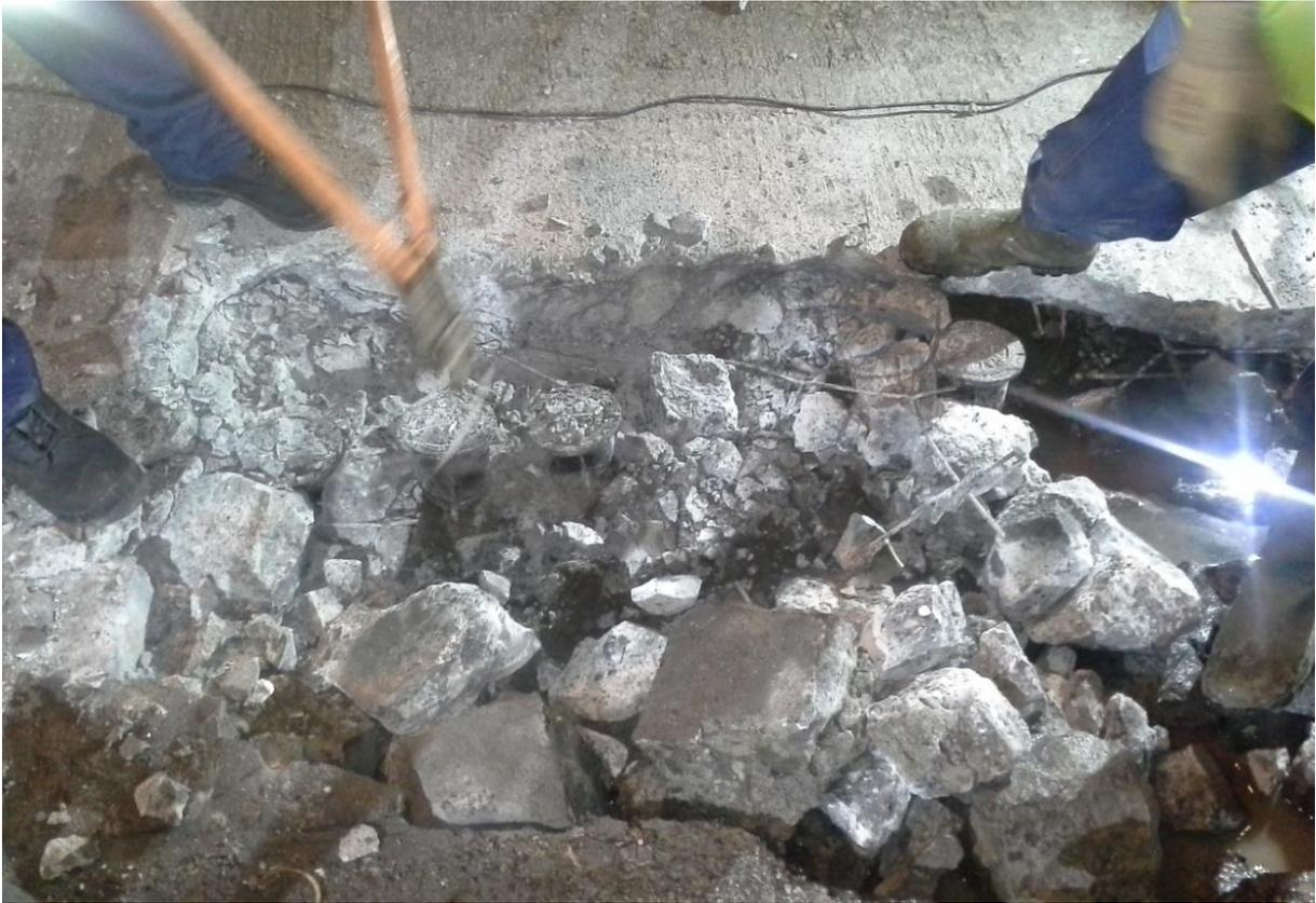
Mise à nu de plusieurs vannes, jusqu'alors inaccessibles
