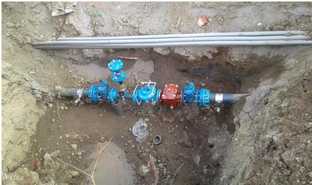
Mise en place du STAB DN80 Les hauts de Maniba (CASE-PILOTE)
