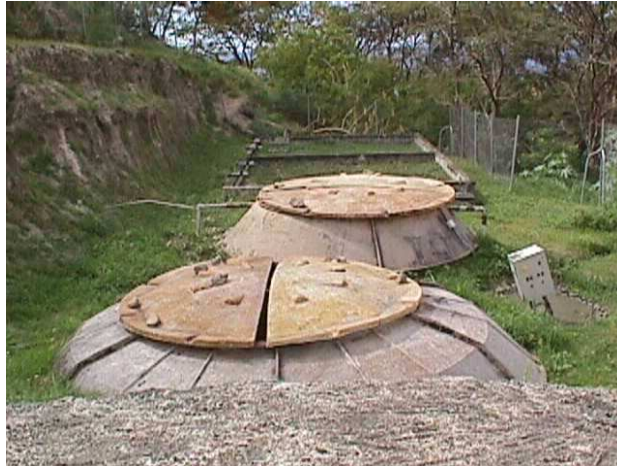
Vue d'ensemble de la station d'épuration Charmeuse 1
