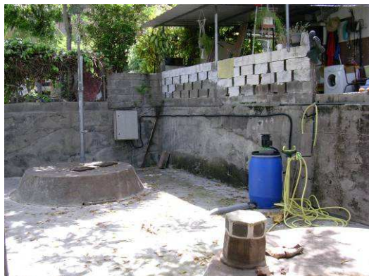
Vue d'ensemble de la station d'épuration
