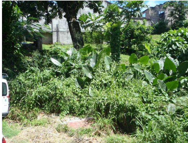
Fosse septique de Bout Bois, le Carbet.
