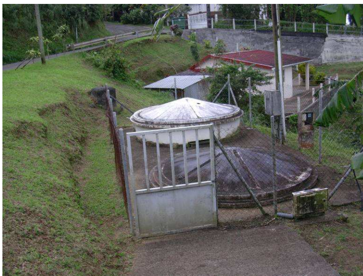
Vue d'ensemble de la station d'épuration
