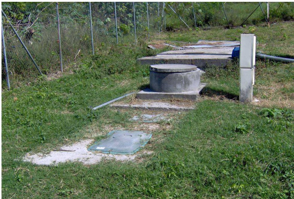
Vue d'ensemble de la station d'épuration
