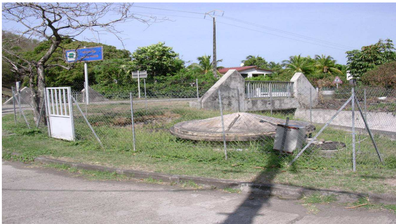
Vue d'ensemble de la station d'épuration
