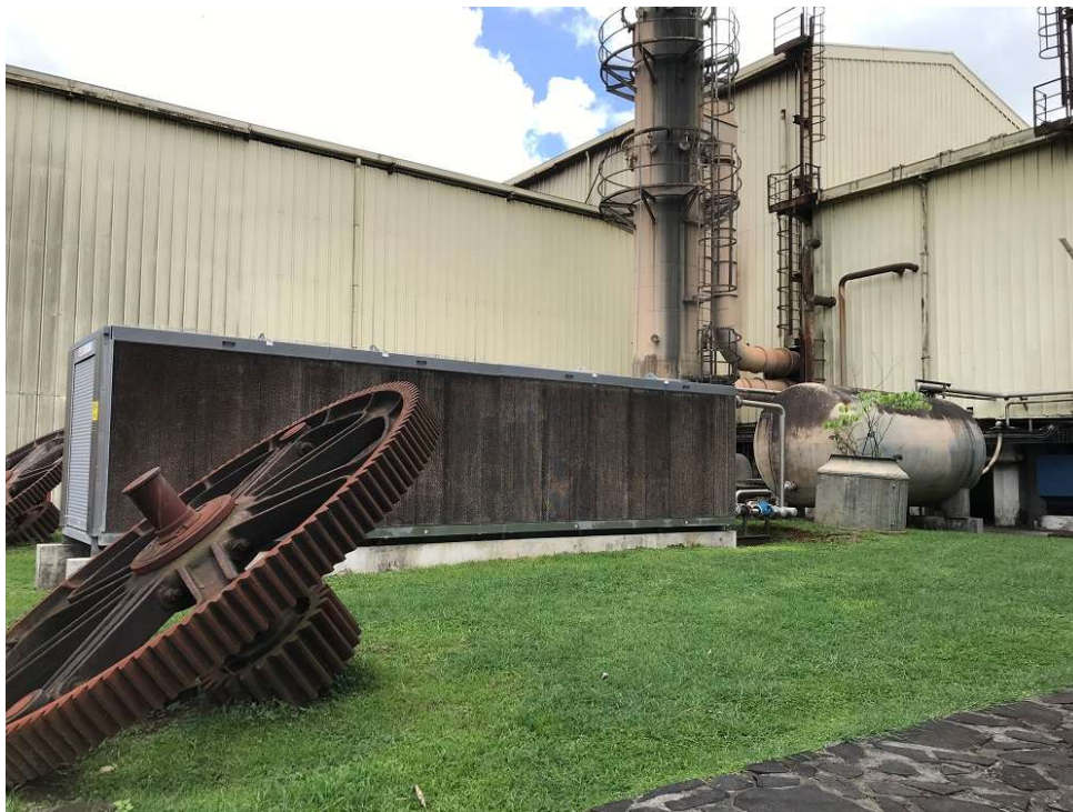
FIGURE 9 : REFROIDISSEUR ADIABATIQUE DE LA MAUNY
