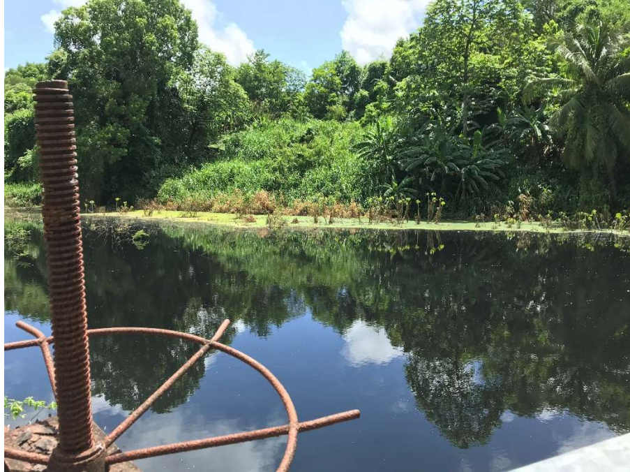
FIGURE 12 : « LAGUNE D » NON AEREE DE LA MAUNY, LAGUNE DE STOCKAGE AVANT REJET EN RIVIERE
