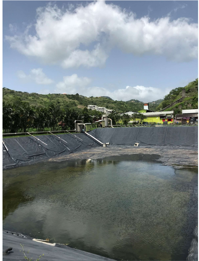
FIGURE 23 : LAGUNE 2 DE LA DISTILLERIE DE NEISSON
