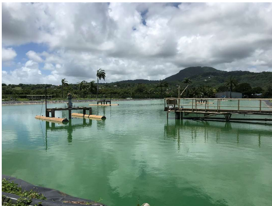
FIGURE 26 : PHOTO DES TURBINES DE LA LAGUNE 1 DE LA DISTILLERIE DU SIMON
