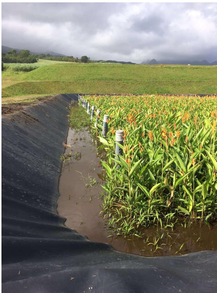
FIGURE 14 : FILTRE PLANTE D'HELICONIA DE LA DISTILLERIE JM
