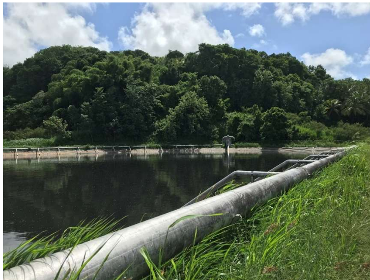
FIGURE 18 : LAGUNE A DE LA DISTILLERIE LA MAUNY
