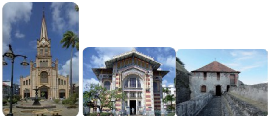
Figure 12 : Monuments historiques classés – Ville de Fort de France (source : Ville de Fort de France)
