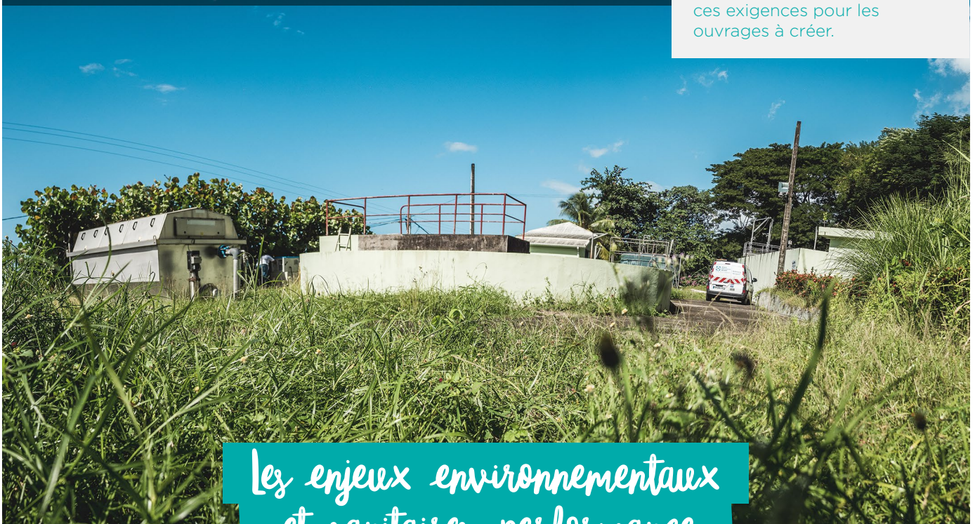
Crédit : L Pelus - Lieu : Saint Pierre, Fond Corré
