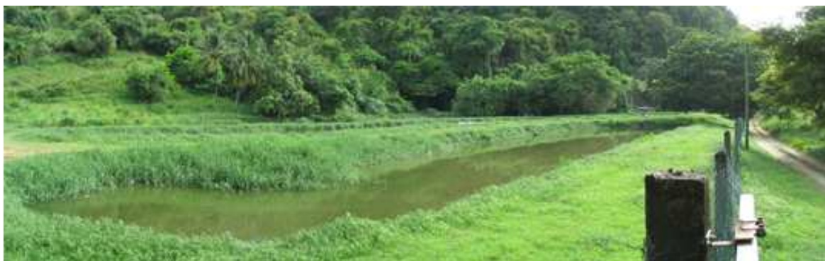
Bassin d'épuration du Carbet
