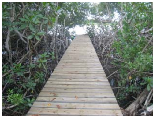
Ponton du parcours de santé du Morne Cabrit
