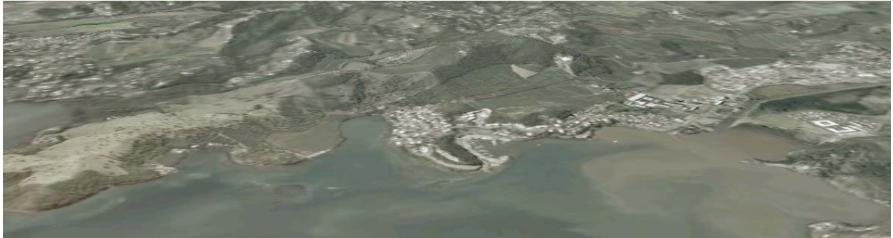
Figure 43 : Vue générale du François (Géoportail 3D, IGN)
