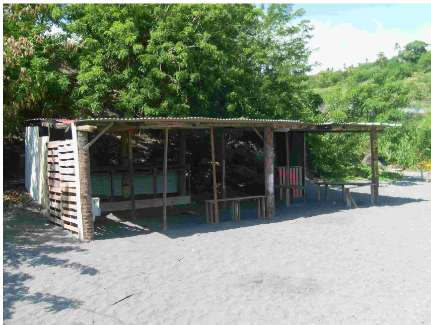
Figure 33: Bâti léger - Coulée Blanche à Saint-Pierre.
