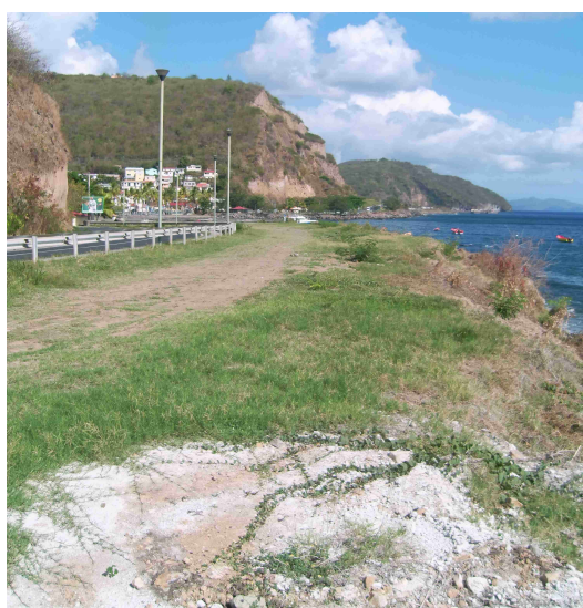
a. Zone de remblais – Entrée nord du bourg de Bellefontaine.
