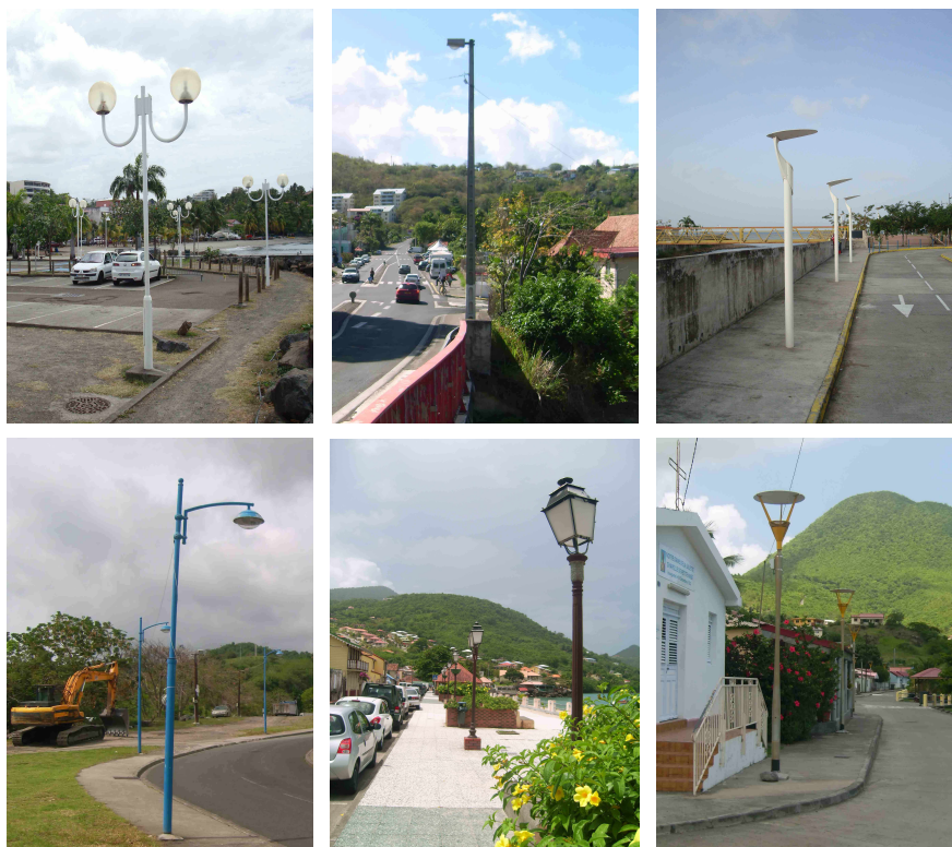
Figure 5: Exemples d'équipements générant une pollution lumineuse forte.
