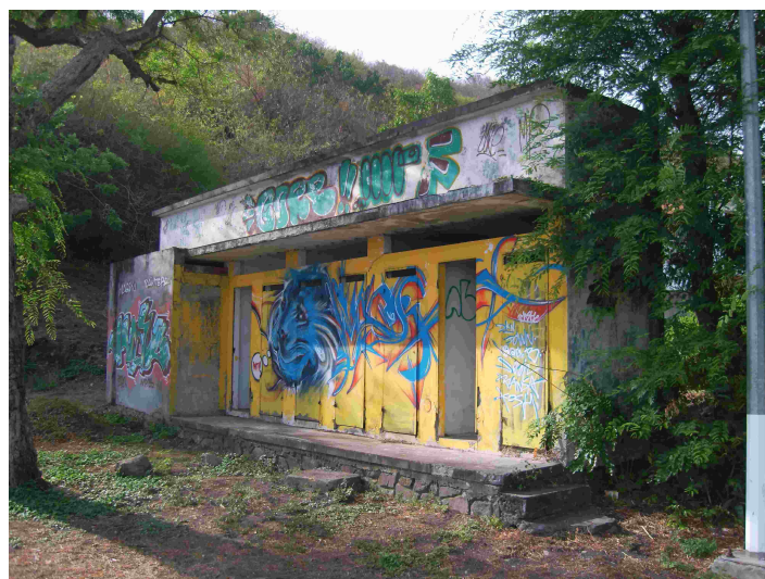
b. Ancien bloc sanitaire ou cabines à détruire ou à réhabiliter
