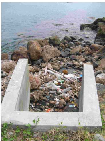
Figure 40: Exutoire d'eaux usées et pluviales - Autre Bord à Case-pilote
