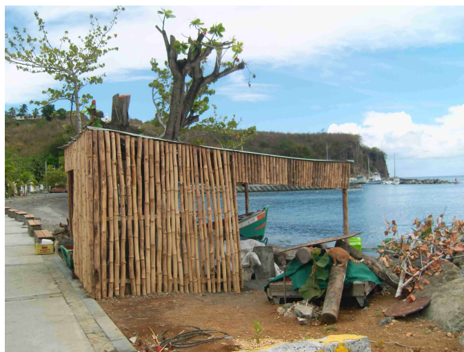
Figure 12: Exemple de bâti léger : un abri de pêcheur en tôle et bambou - Bourg de Case-Pilote.
