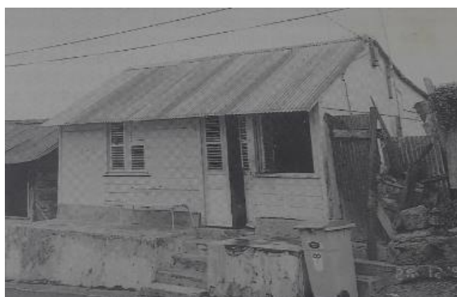
Figure 19 : Case en béton et tôle en milieu urbain (S. Letchimy, 1992)
