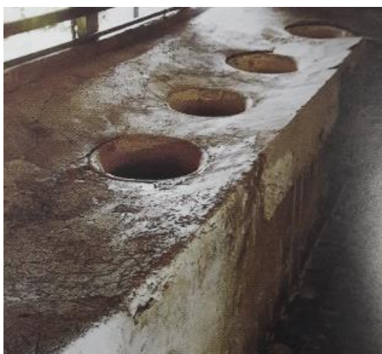
Figure 9 : Cases à eau au Vauclin (Fondation Clément, 2012)
