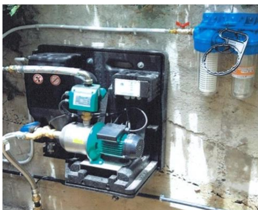
Figure 78 : surpresseur-gestionnaire avec filtration duo (anti calcaire et anti impureté en aval)
