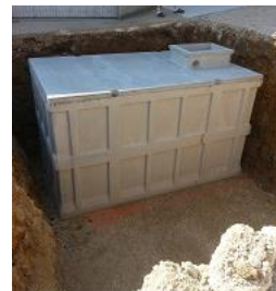
Figure 40 : Cuve enterrée en béton
