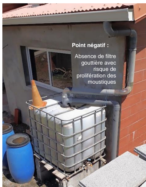
Figure 53 : Système SREP avec cuve IBC sur construction neuve
