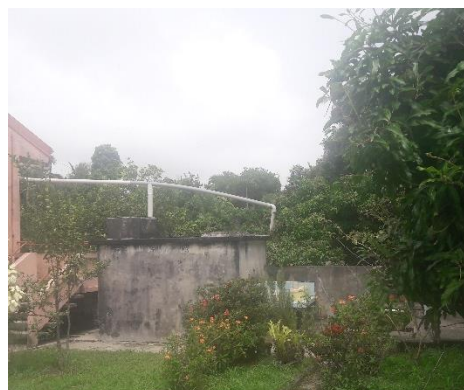
Figure 33 : Ancienne citerne en béton, dans maison moderne. 2020, Basse-Pointe
