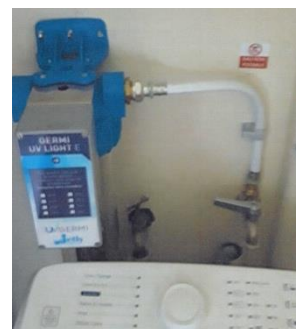
Figure 80 : lampe UV en entrée d'alimentation du lave-linge
