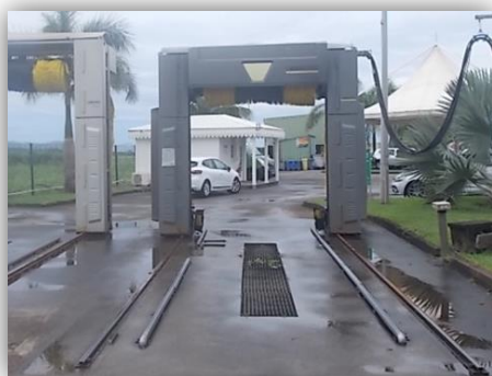
Portiques de nettoyage innovants (basse consommation d'eau) et cuve souterraine
