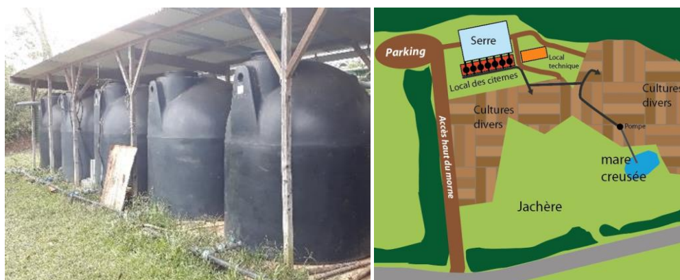
Figure 61 : Sept cuves de 5500 litres interconnectées et alimentées par les toitures
