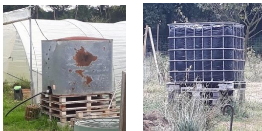
Figure 55 : solutions alternatives pour éviter l'eutrophisation : cette exploitation couvre les cuves par différents moyens : bâche, tôles soudées
