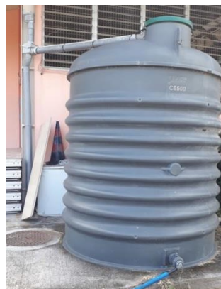
Figure 87 : Photographie du système installé
