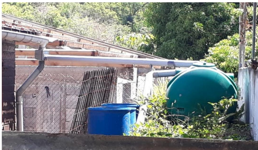
Figure 60 : Photographie d'un SREP avec cuve en PE
