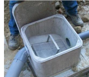
Figure 38 : Exemple de filtre en entrée de cuve
