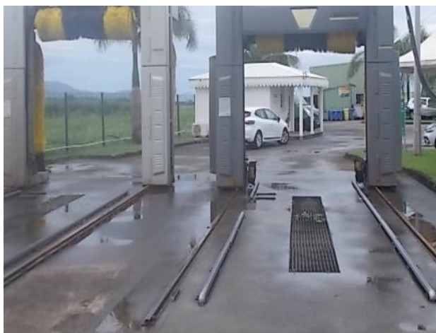
Figure 94 : le portique de lavage est équipé d'une cuve souterraine qui récupère l'eau filtrée et d'un débourbeur. L'eau de pluie est récupérée, utilisée puis traitée et réinsérée dans le réseau de nettoyage.
