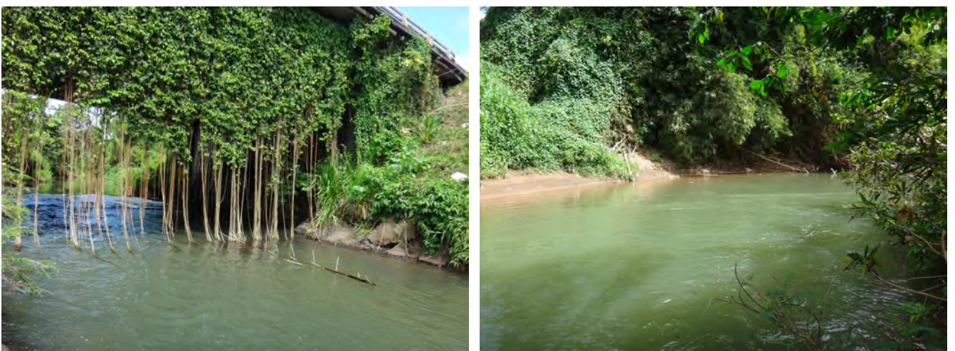
Figure 166 - Lézarde au pont de la RN1 - Station n°08504102 - 2018 - SCE
