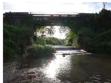
Vue de la limite amont
