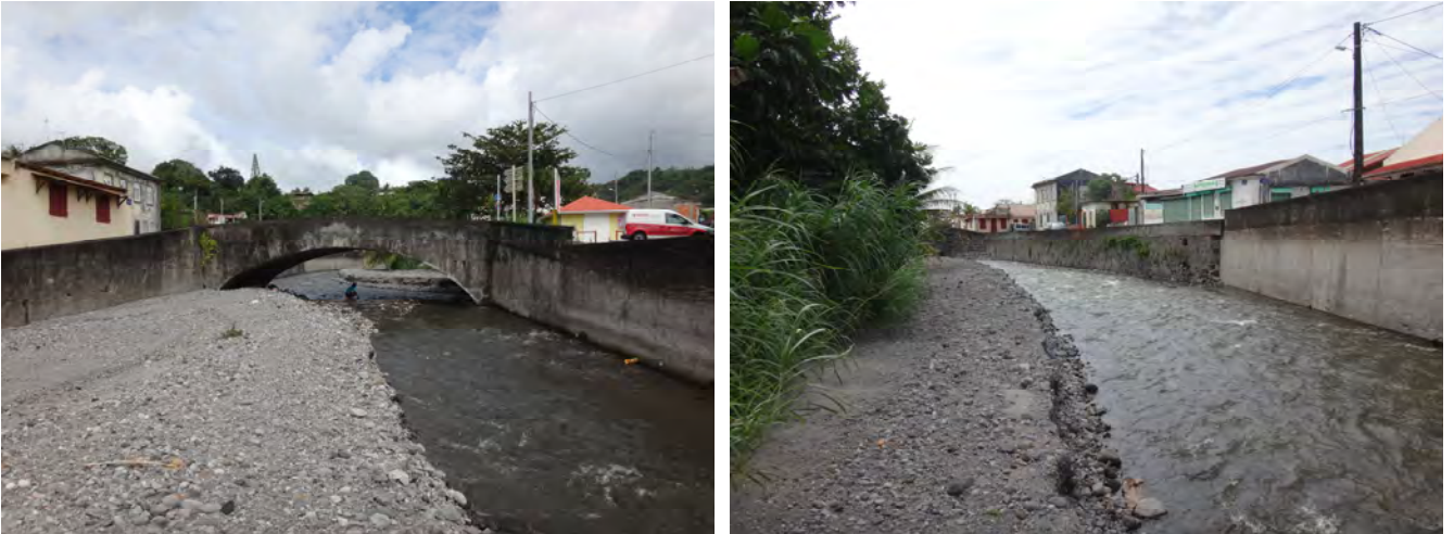
Figure 8 - Atterrissement en aval (photo de gauche) et en amont du pont (photo de droite) - Station n°08329101 - 2018 - SCE
