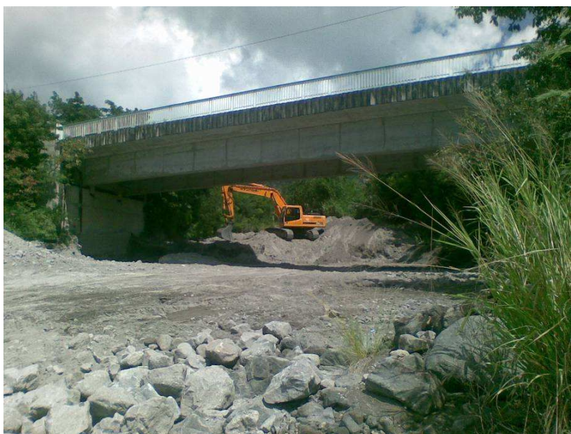
Pont de la rivière sèche les engins chargés du curage peuvent toucher la conduite passant dans la rivière
