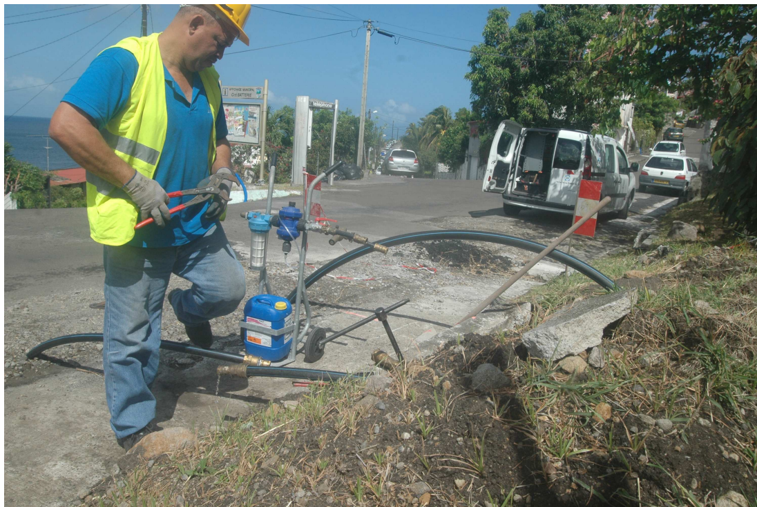
Renouvellement des canalisations à petit fourneau CASE-PILOTE : désinfection avant mise en service
