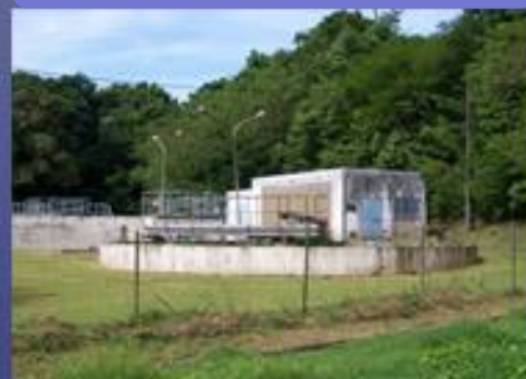
STATION D'ÉPURATION DE FOND LAHAYE SCHOLECHER
