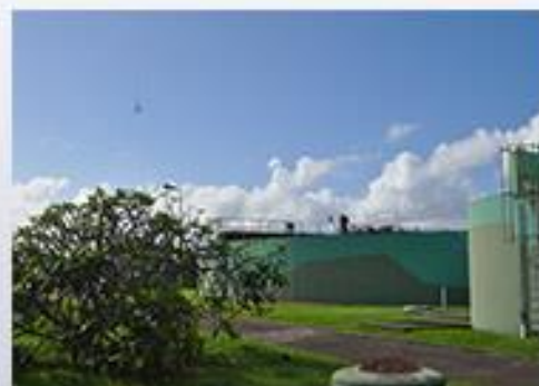
STATION D'ÉPURATION DE DILLON FORT DE FRANCE
