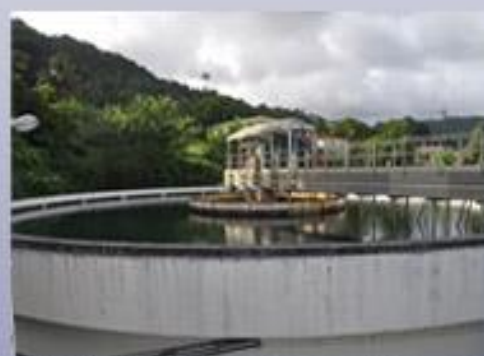
STATION D'EAU POTABLE DE DURAND ST JOSEPH
