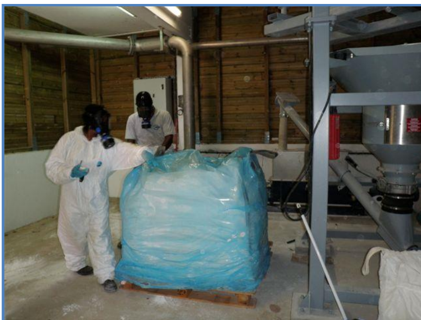
Manutention des bigs-bags de chaux
