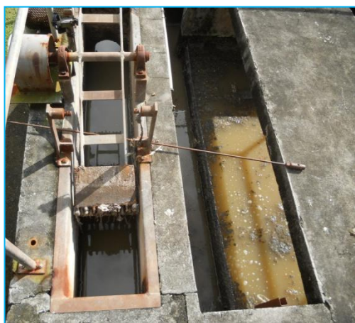
Dégrilleur step Marigot bourg avant renouvellement
