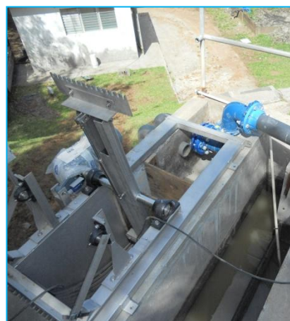
Dégrilleur step Marigot bourg après renouvellement
