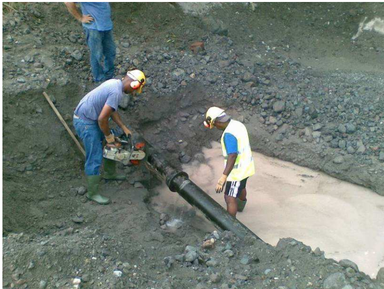
Réparation de la casse sur la conduite d'alimentation du PRECHEUR dû à l'engin chargé du curage.
