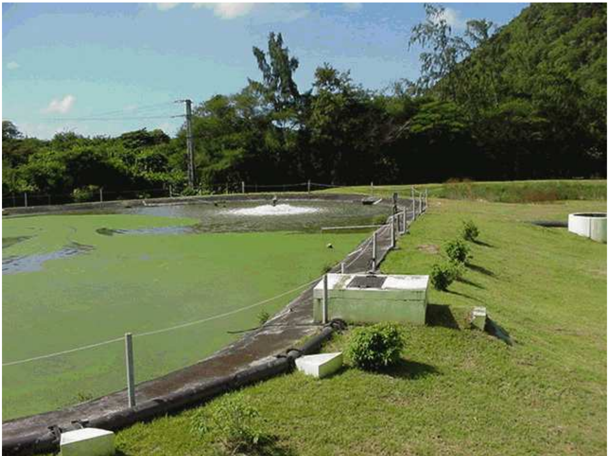
Station d'eaux usées du bourg
