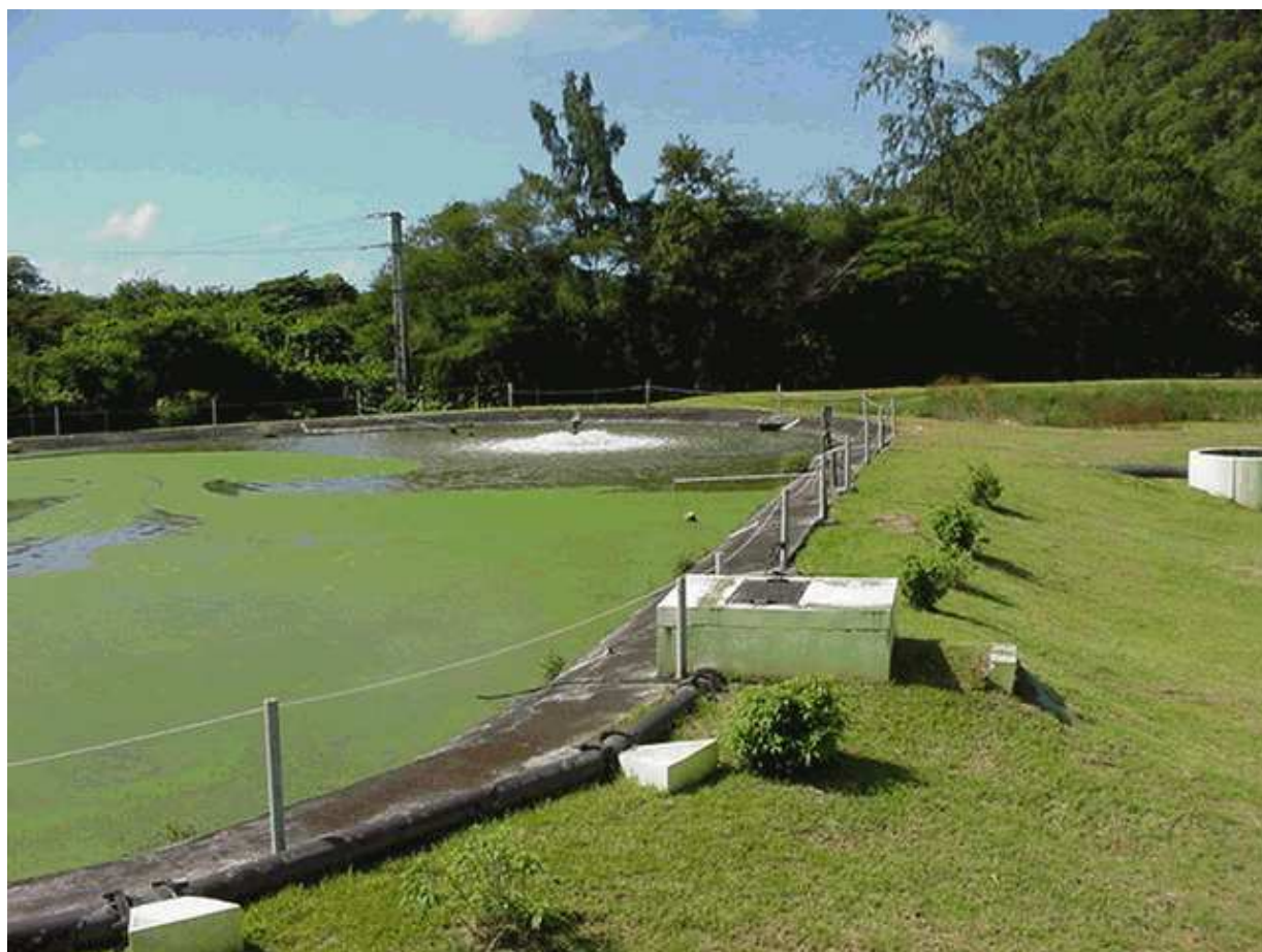
Station d'eaux usées du bourg
