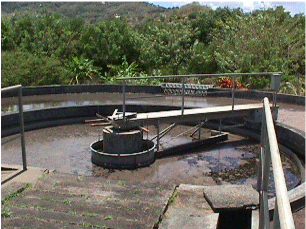
Station de Traitement d'eaux usées du Bourg
