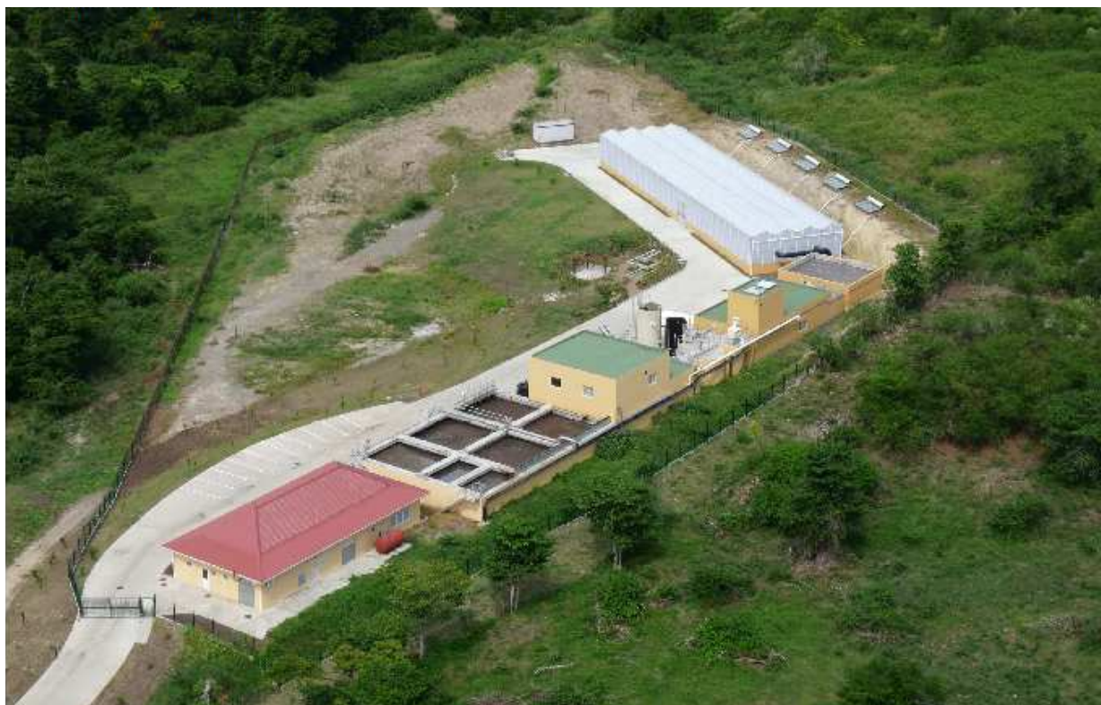
Station d'épuration des 4 Chemins
