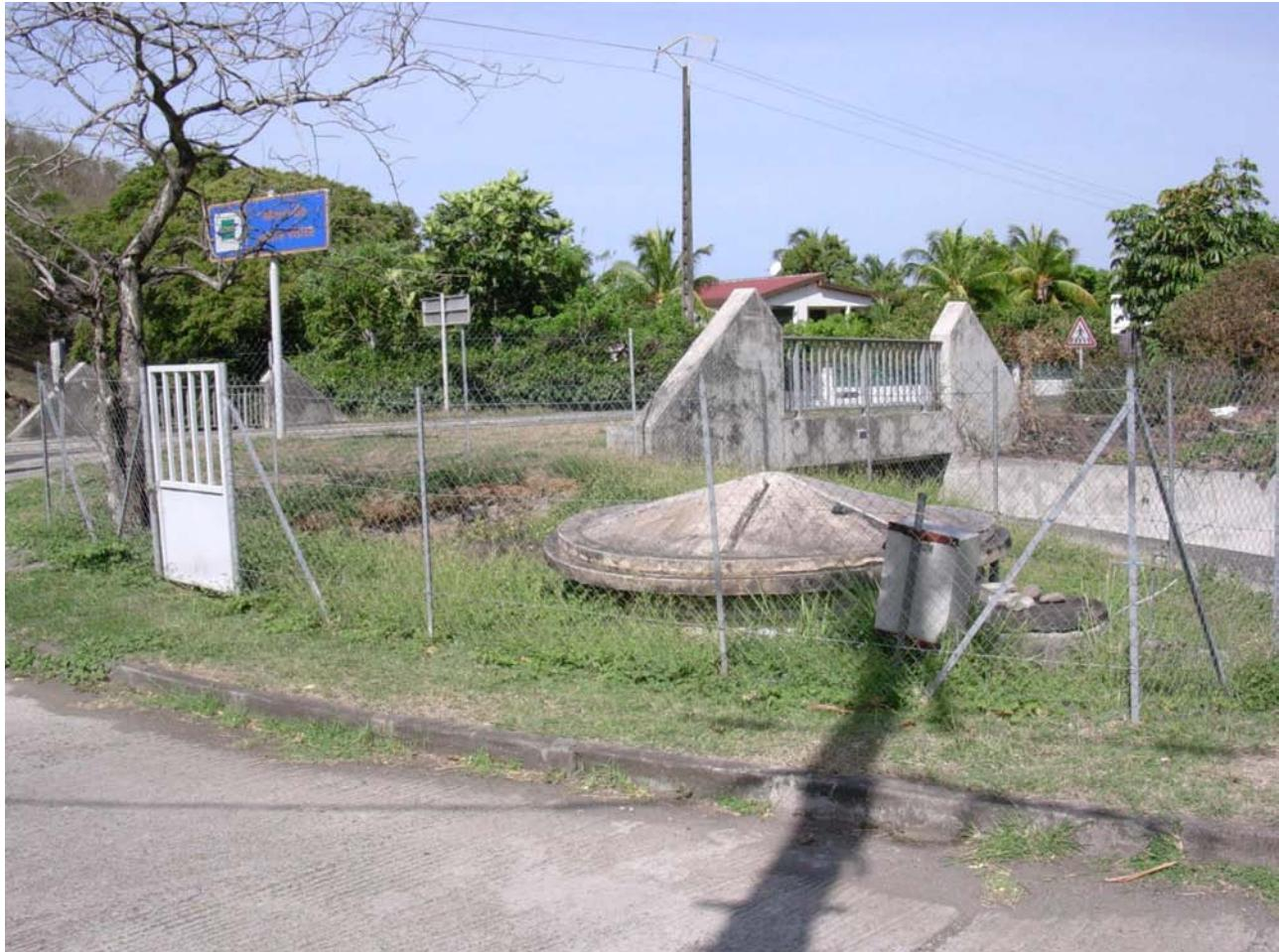
Cette station d'épuration OXYVOR de type boues faible charge, à capacité nominale équivalente à 80 éq.hab.
