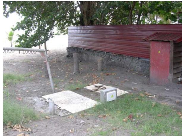
La canalisation de trop plein, existante sur ce poste n'est pas équipée d'un système de comptage des effluents by passés.
