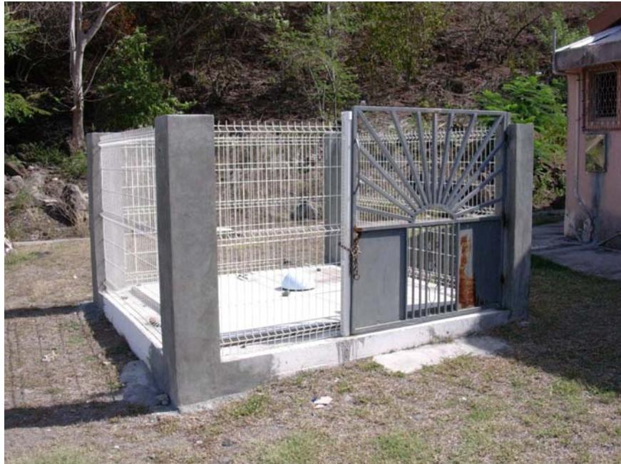
Station d'épuration de type OXYVOR à aération prolongée, de capacité nominale équivalente à 80 éq.hab.
