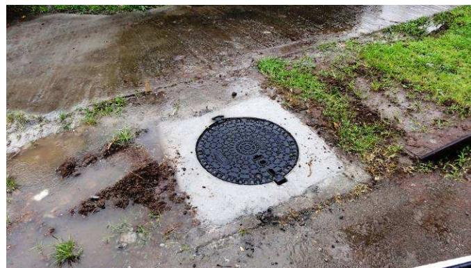
**Photo 10: Exemple de remplacement par un tampon conforme**
