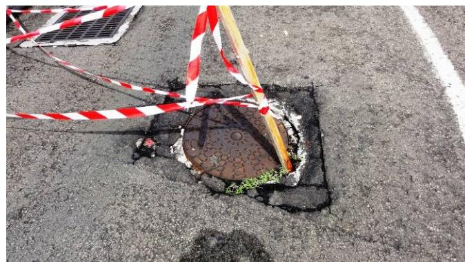
**Photo 9: Exemple de tampon non conforme rue du collège**
