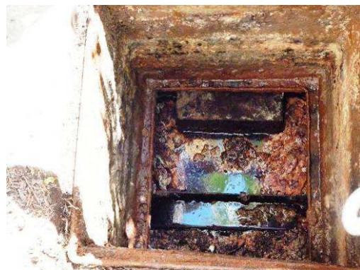
**Photo 7 : Exemple de boîte à graisse d'un restaurateur**
