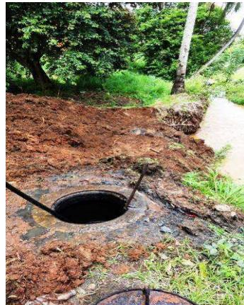
Photo 4: Exemple de regard inaccessible et en zone inondable
