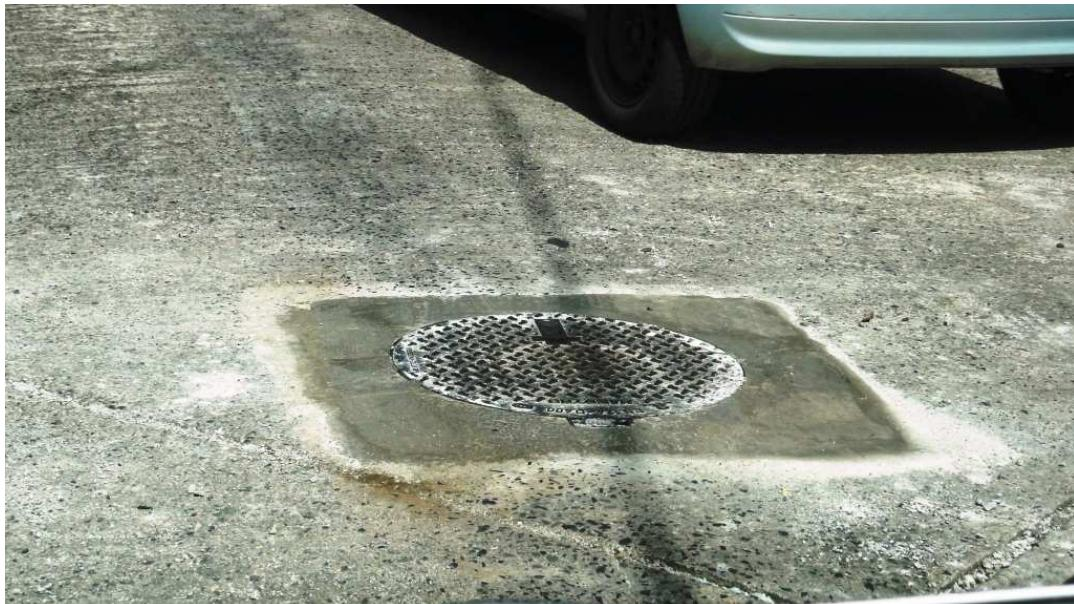
**Photo 5: Exemple de tampons hydrauliques mis en conformité**
