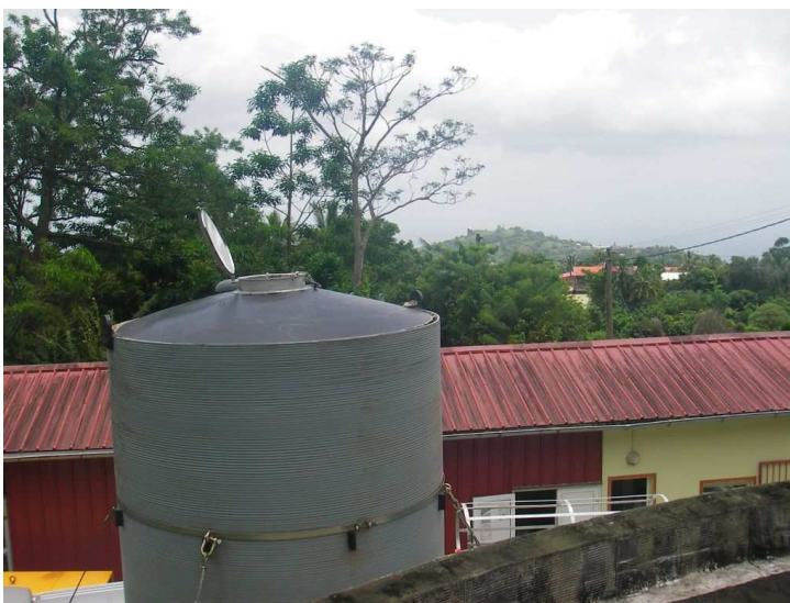
L'accès à la bête de rétrolavage se fait désormais par le haut
