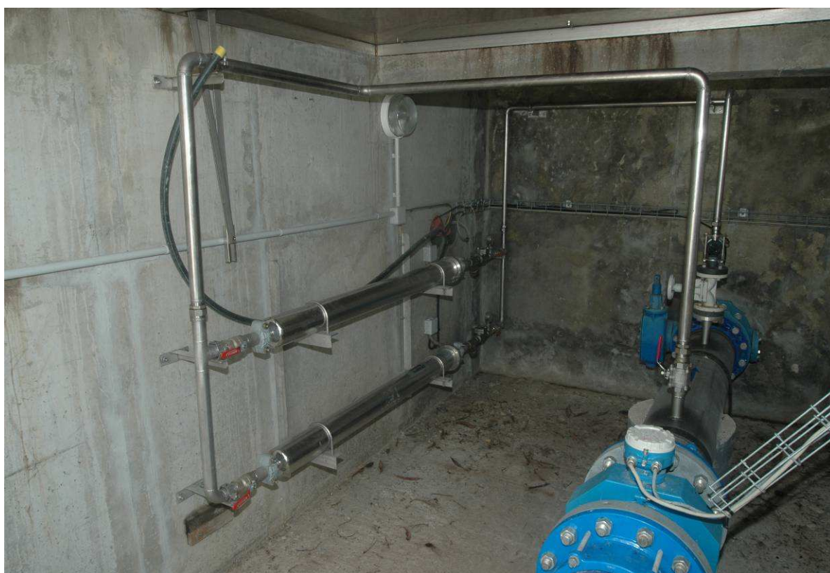
Chloration située au lieu-dit Pécou, assurant une désinfection sur l'ensemble de l'adduction branche Sud
