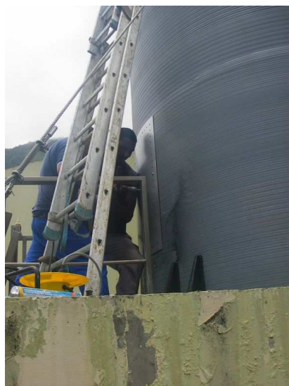
Mise en place d'une plaque en inox en lieu et place du trou d'homme
