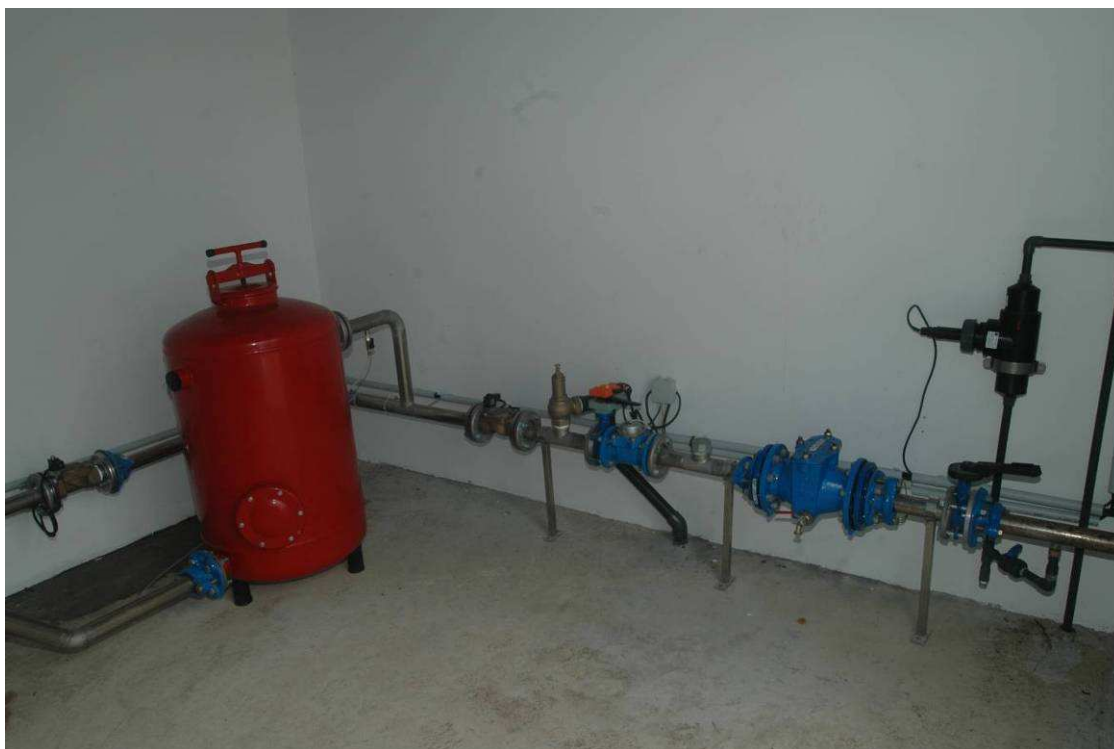
Installation d'une unité de filtration au réservoir de Verrier
