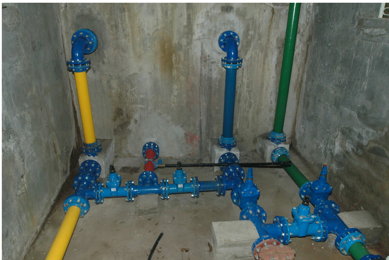
Renouvellement de la salle de manœuvre de La Croix
