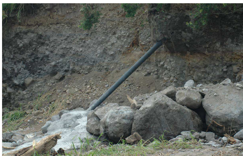
La conduite d'adduction traversant la Roxelane est dans le vide depuis le cyclone DEAN août 2007 : une crue importante risque de l'emporter de nouveau
