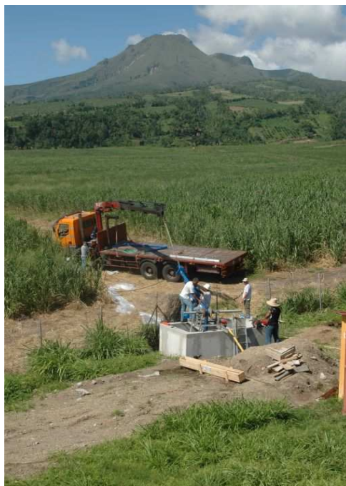
Mise en place du forage FR8 à Pécoul
