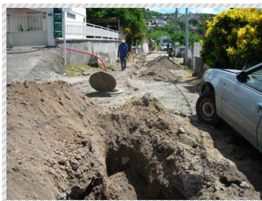
POSE DE PVC DN 125 IMPASSE SAPOTILLE
