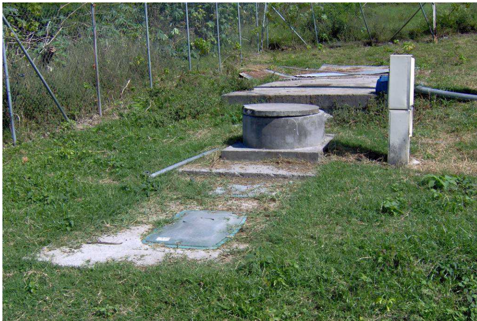
Vue d'ensemble de la station d'épuration
