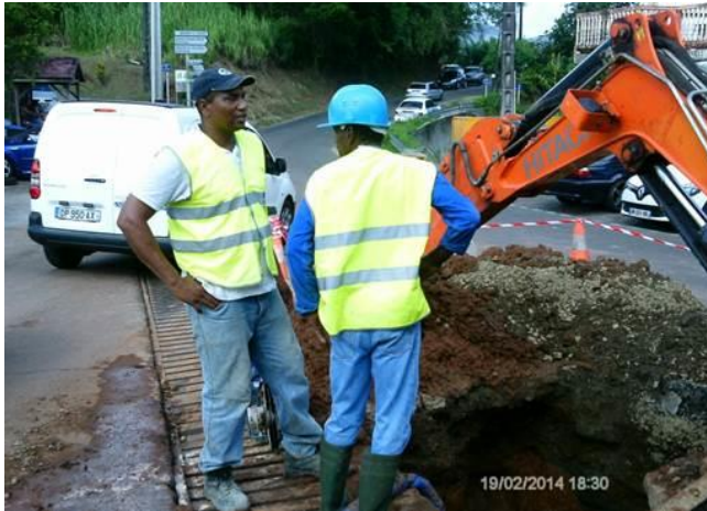
Fouille et évaluation des réparations : fuite sur Té collé entre la canna 150 adduction du galion vers bonneville et piquage réseau Morne des Esses
