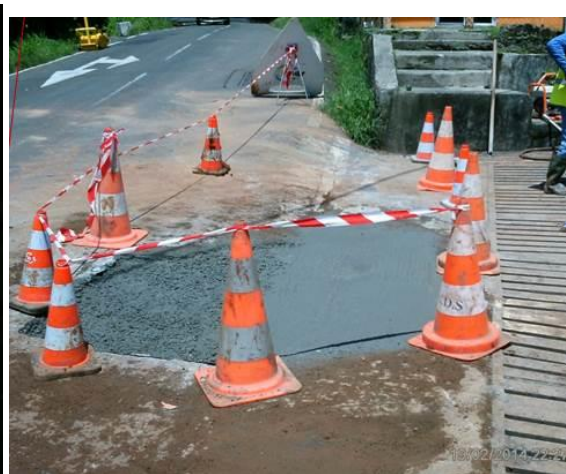
Fin du chantier, réfection béton pour attente enrobé
