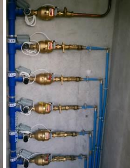
Pose de compteur sur les pallier colonne montante avant équipement de télérelève
