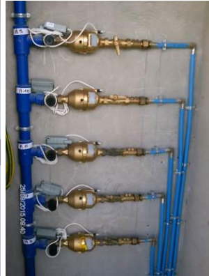
Pose de compteur sur les pallier colonne montante avant équipement de télérelève
