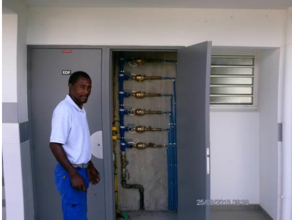
Pose de compteur sur les pallier colonne montante avant équipement de télérelève
