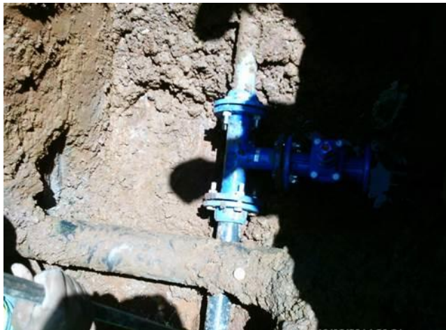
Mise en place Té DN60 et vanne d'isolement en fonte DN75 Réseau Morne des Esses
