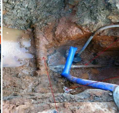
Fouille et évaluation des réparations : fuite sur Té collé entre la canna 150 adduction du galion vers bonneville et piquage réseau Morne des Esses
