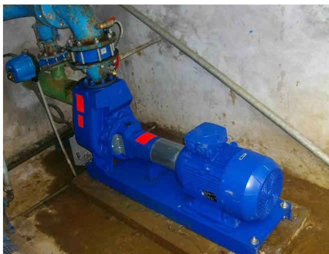
Renouvellement des pompes et des vannes motorisées prise d'eau en rivière du Galion :
