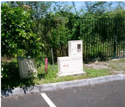
Pose des compteurs extérieurs : Station d'épuration, vestiaires et local poubelles
