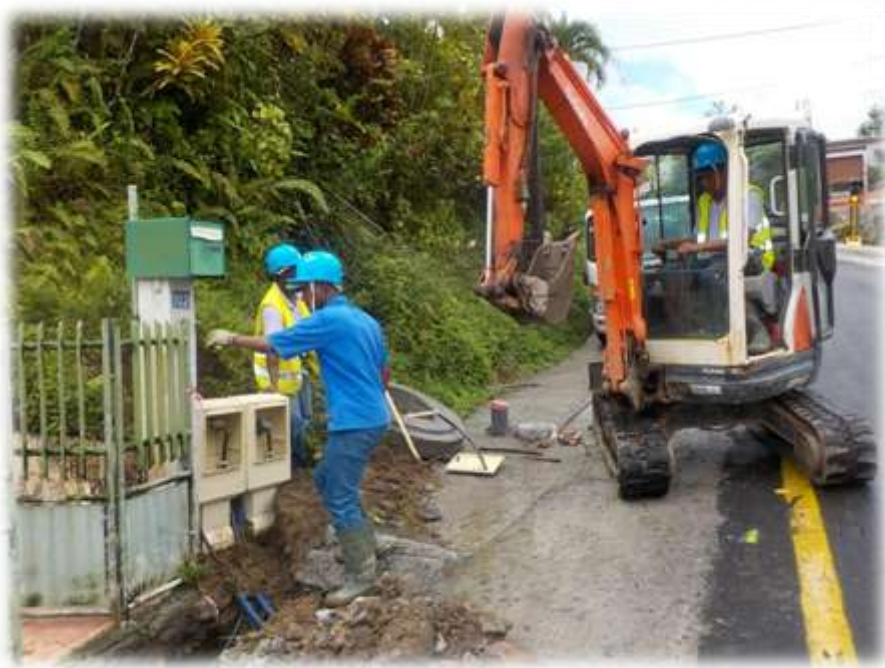
Photos Branchements Ajoupa Bouillon
