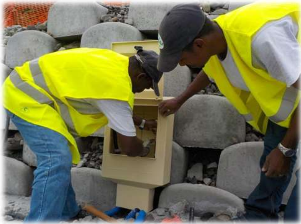
Photos Branchements Ajoupa Bouillon
