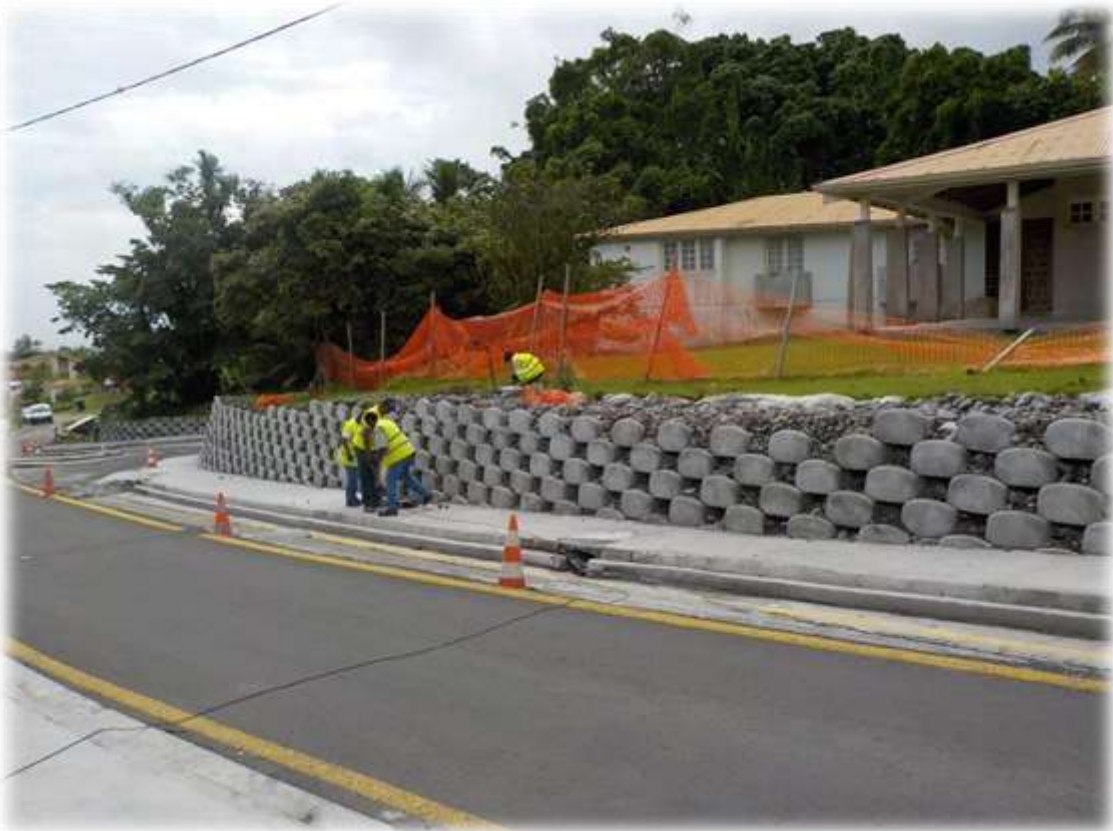
Photos Branchements Ajoupa Bouillon
