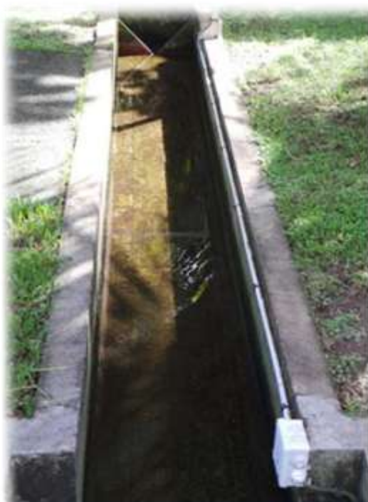
Débitmètre eau traitée posé et connecté
