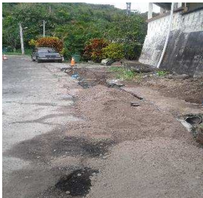
Renouvellement canalisation Les Abymes (Prêcheur)
