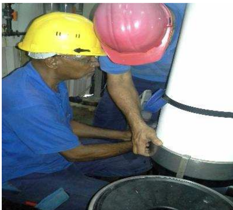
Mise en place des nouveaux modules : un travail minutieux d'ajustement des blocs de 60 kg chacun est nécessaire.
