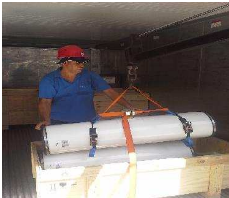
Dépotage des nouveaux modules
