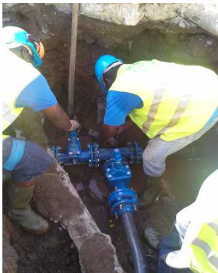
Mise en place de vannes neuves
