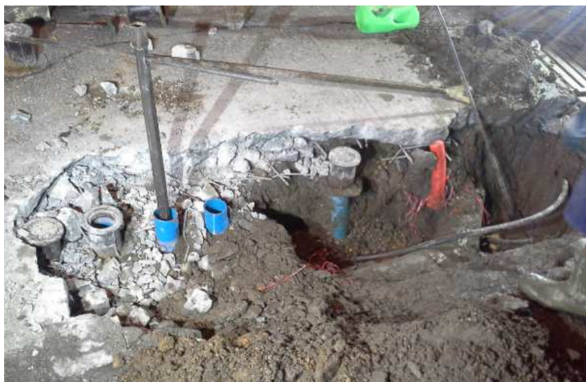
Tests de fonctionnement avant remise à niveau
