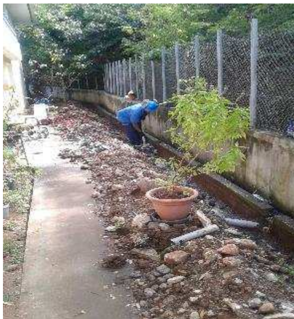
Renouvellement canalisation LAJUS (Carbet)
