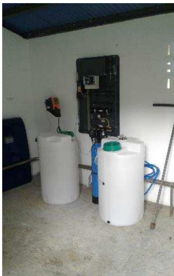
Dispositif électrochloration Verrier (Bellefontaine)
