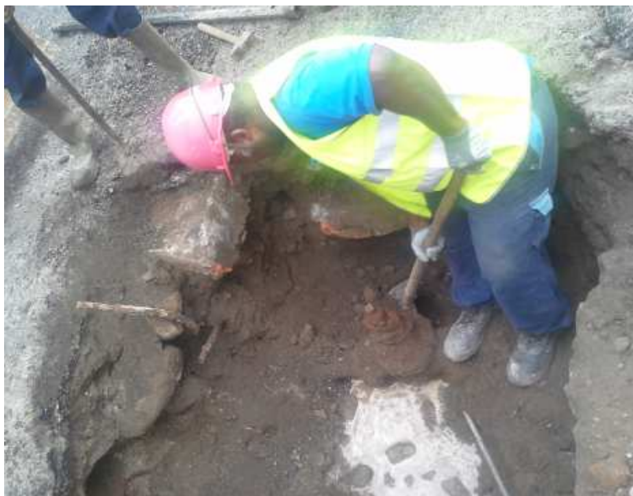
Dégagement d'une vanne existante
