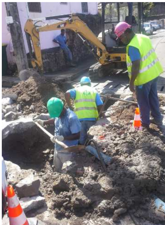
Terrassement sous chaussée goudronnée pour atteindre les vannes
