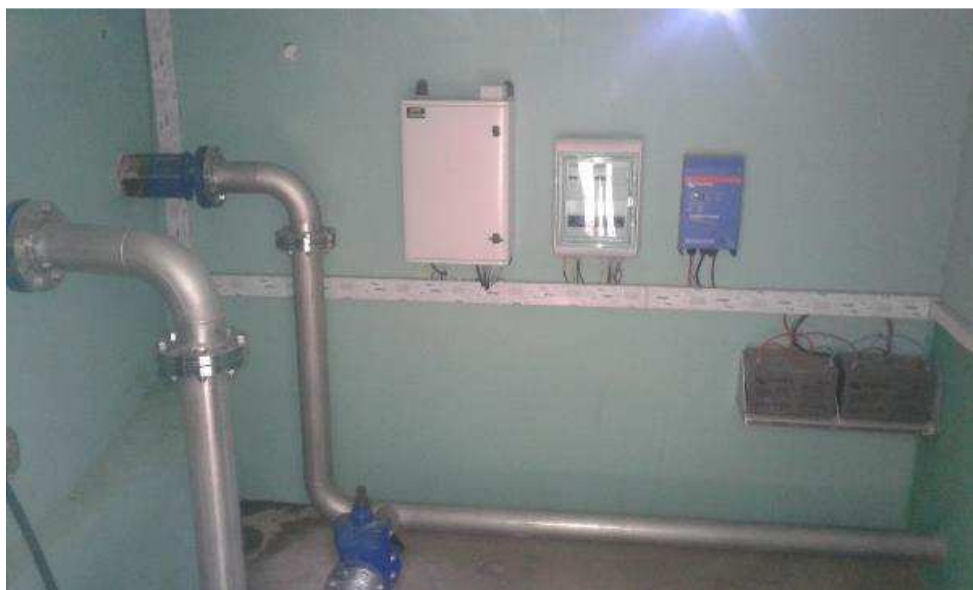
Renouvellement chambre de manœuvres Réservoir Anse belleville (Prêcheur)
