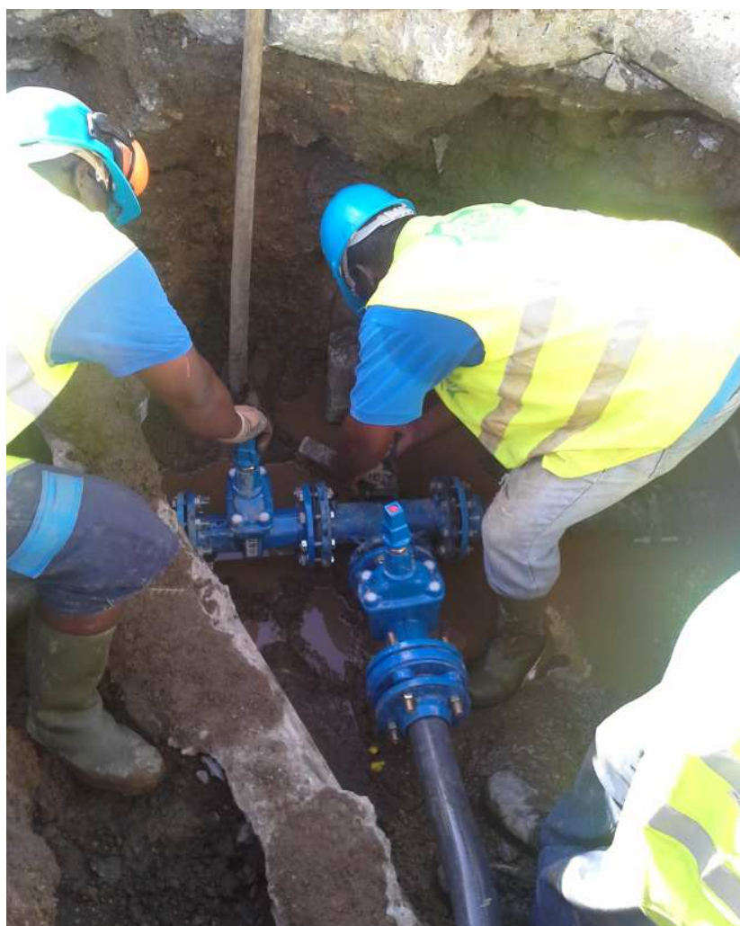
Mise en place de vannes neuves
