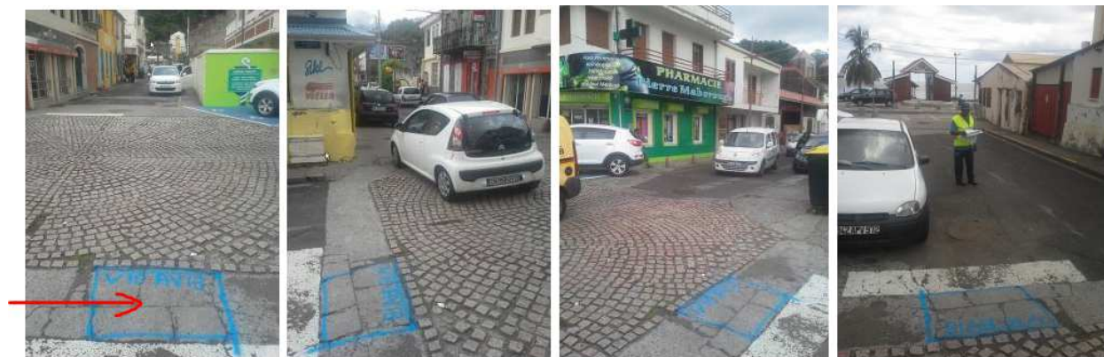
Localisation présumée de 4 vannes à l'angle des rues Général de Gaulle et rue Victor HUGO : Les vannes sont recouvertes sous une épaisseur d'enrobé et de pavés.
