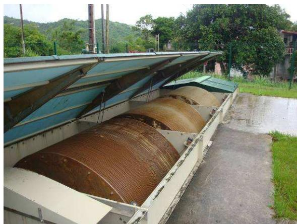
Filtration des eaux usées des stations d'épuration.
