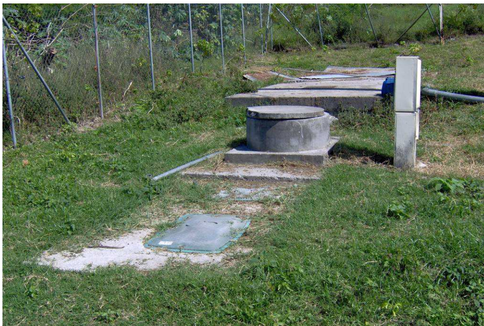
Vue d'ensemble de la station d'épuration
