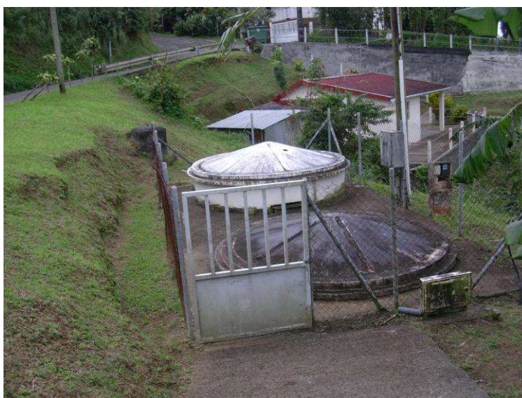
Vue d'ensemble de la station d'épuration
