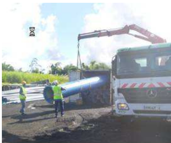
Livraison d'un tuyau en fonte de 800 mm de diamètre pesant plusieurs tonnes.
