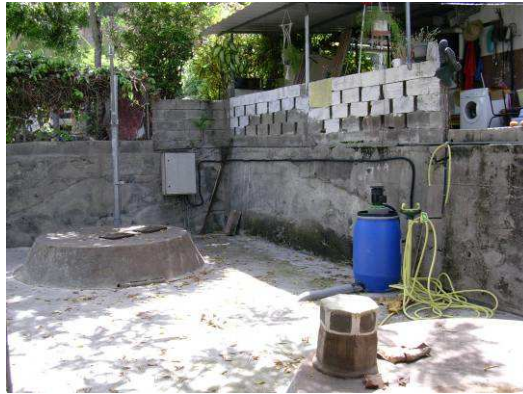
Vue d'ensemble de la station d'épuration
