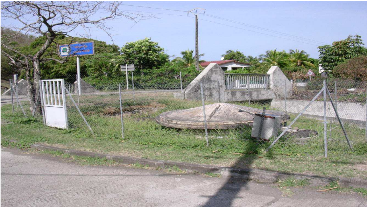
Vue d'ensemble de la station d'épuration
