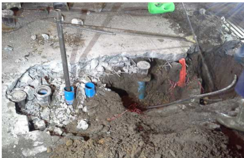
Tests de fonctionnement avant remise à niveau
