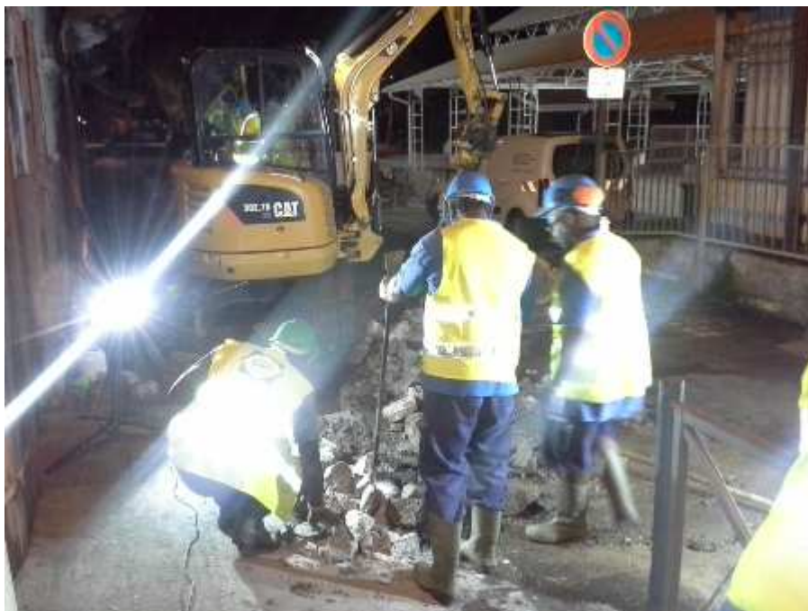
Démolition de la chaussée pour mettre à nu les vannes.
