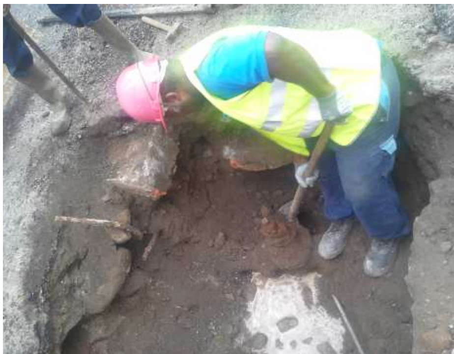
Dégagement d'une vanne existante
