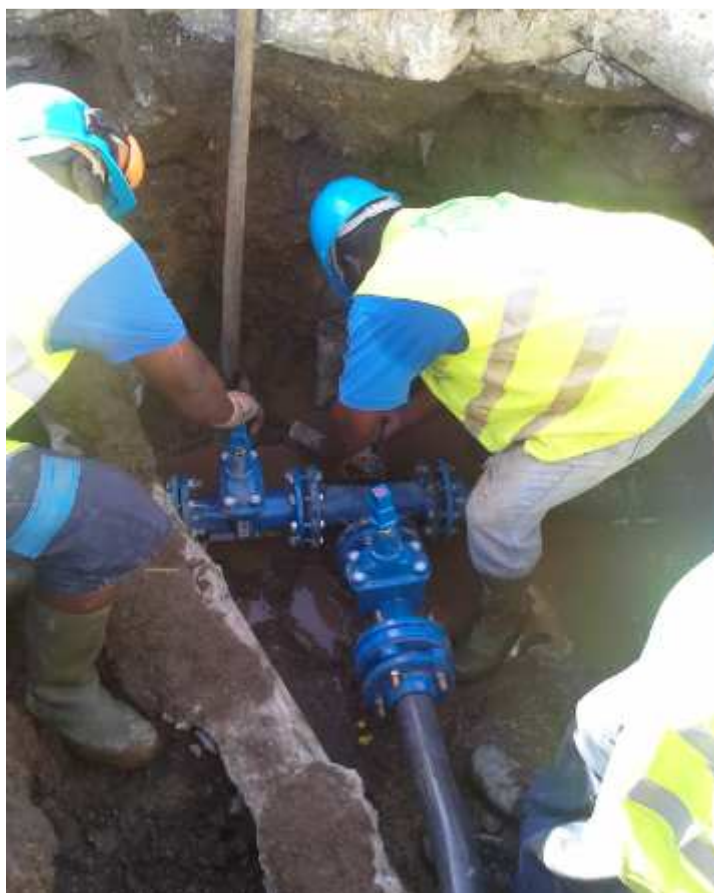
Mise en place de vannes neuves
