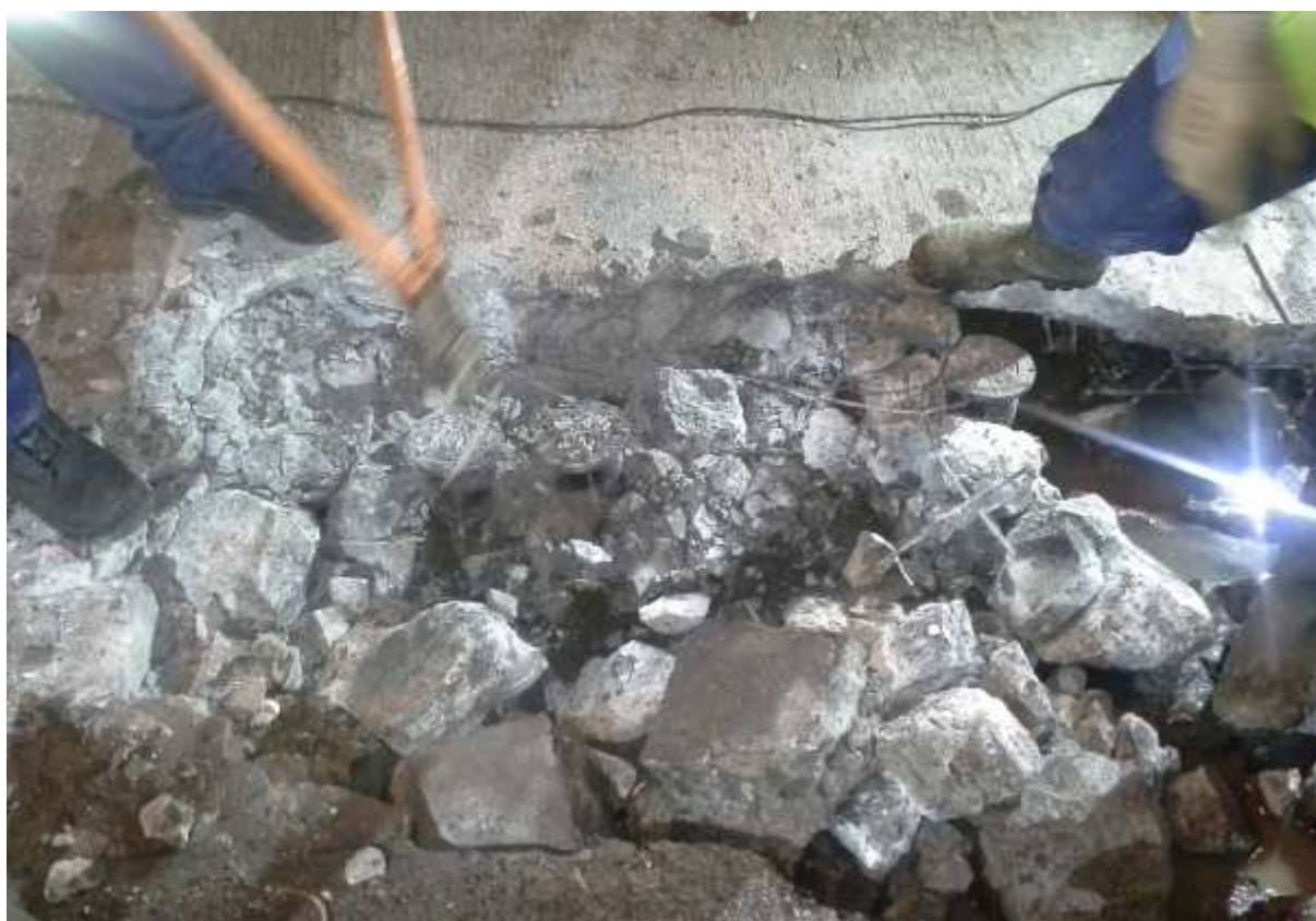
Mise à nu de plusieurs vannes, jusqu'alors inaccessibles
