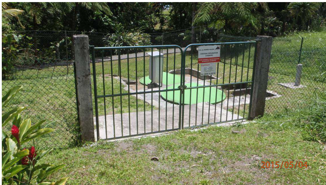
STEU Adapei - Station de type aération prolongée OXYVOR (200 éq.hab).
