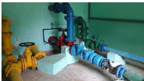
Chambre de vannes
