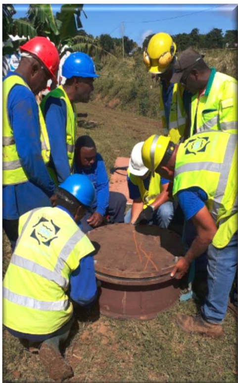
Préparation et montage de la plaque pleine qui sera posée en amont de la rivière côté Trinité
