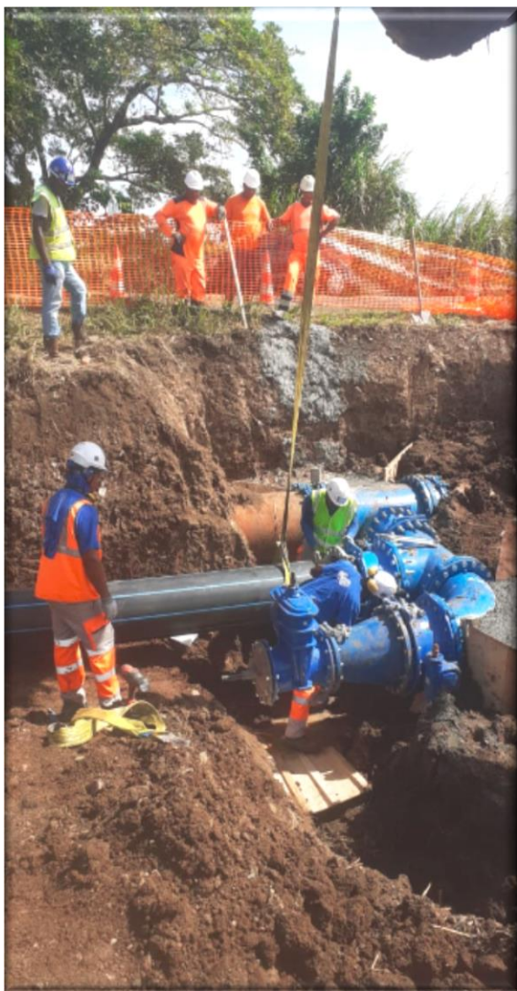
Montage du bypass, pose des canalisations
