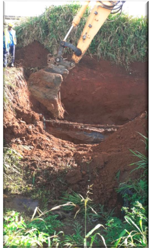
Dégagement de la DN700 avant pose de la plaque pleine
