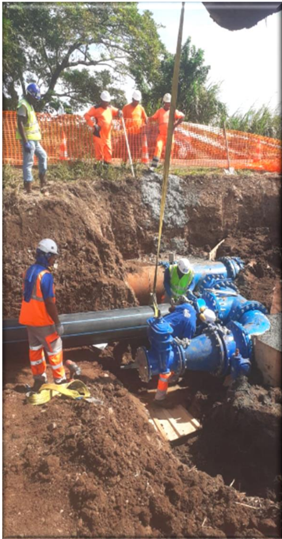
Montage du bypass, pose des canalisations
