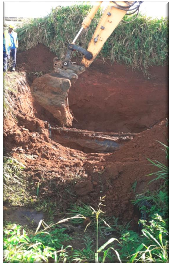
Dégagement de la DN700 avant pose de la plaque pleine
