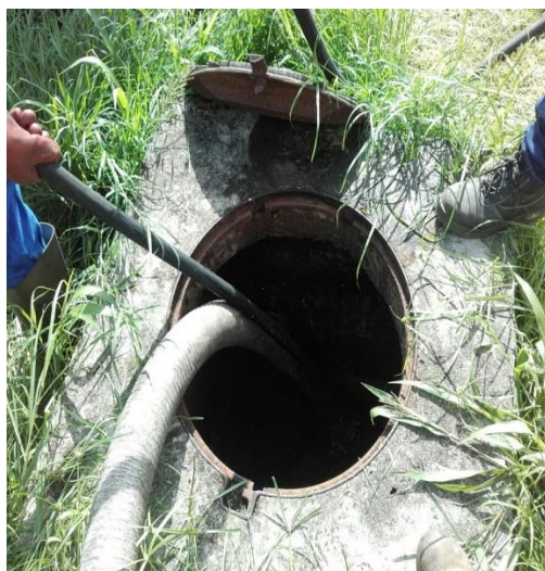
Dégorgement réussi sur environ 60 ml linéaire depuis le réseau en amont :
