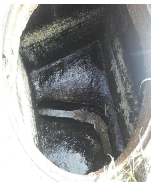
Dégorgement réussi sur environ 60 ml linéaire depuis le réseau en amont :
