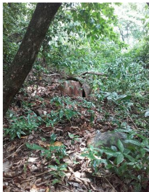
Regard 2 : En très mauvais état
