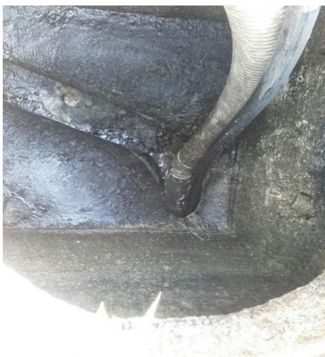
Dégorgement réussi sur environ 60 ml linéaire depuis le réseau en amont :
