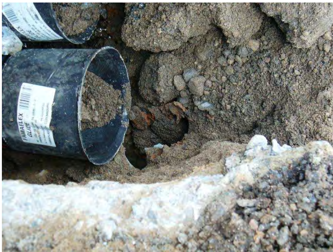
Photo 7: Effondrement du réseau amiante ciment
