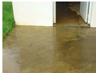
Inondation local électrique bis
