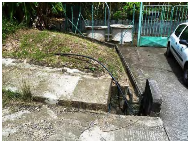
Photo 1 : Ecoulement d'eaux usées dans le réseau d'eau pluviale devant du PR Jolie Cour
