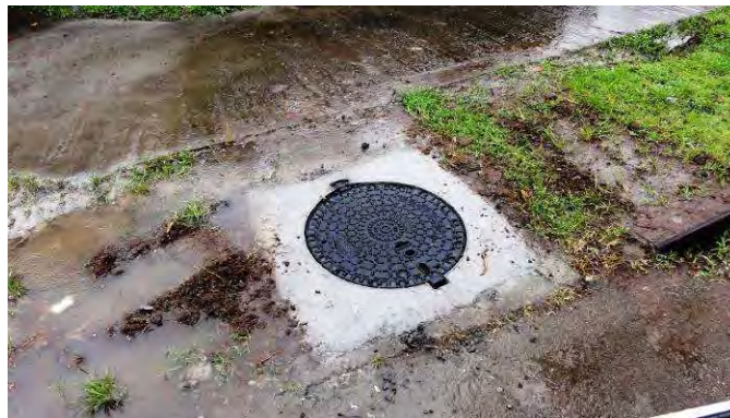
Photo 13: Exemple de remplacement par un tampon conforme
