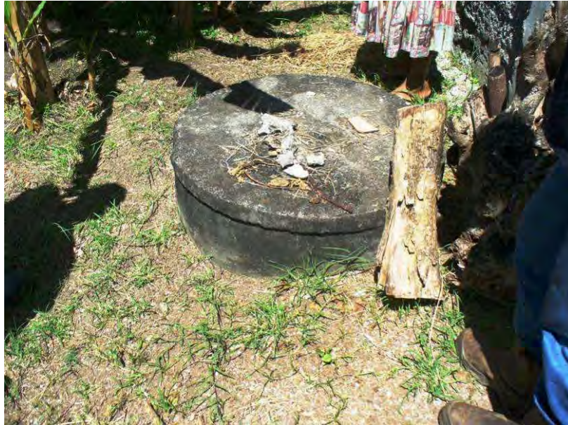
Photo 3 : Exemple de tampon en béton chez l'habitant
