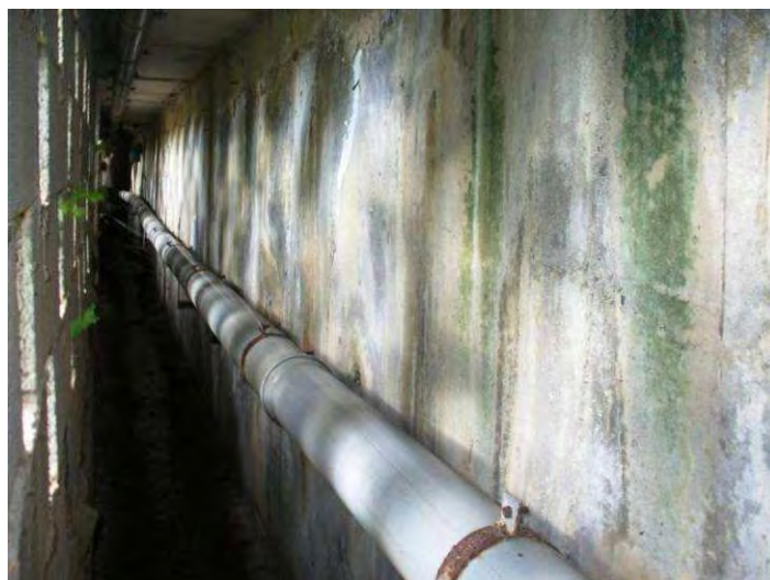
Photo 8 : Galerie de passage des eaux usées, pluviales et eau potable
