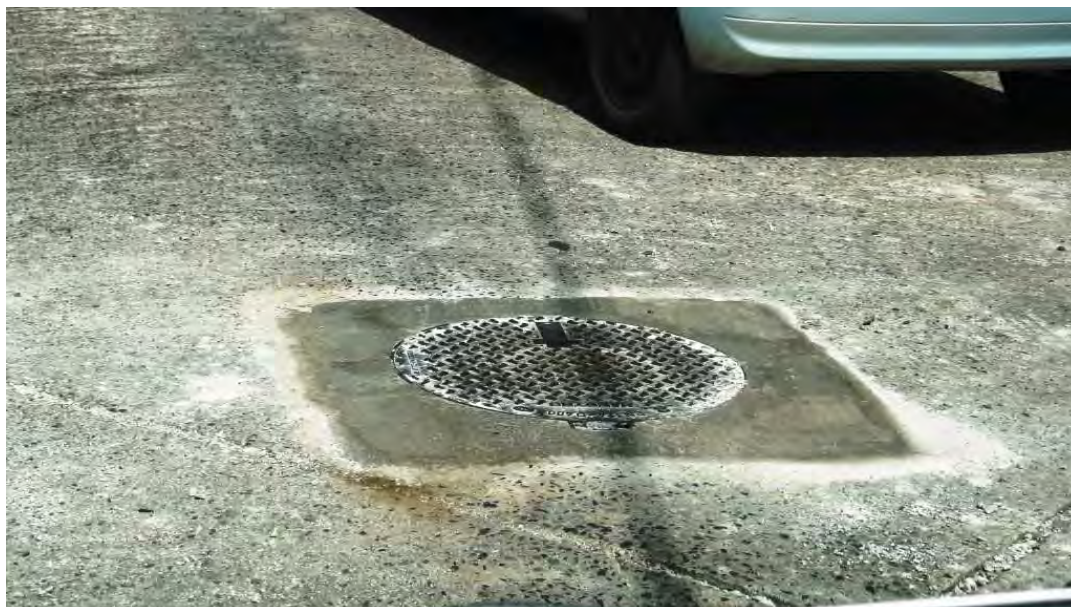
Photo 8: Exemple de tampons hydrauliques mis en conformité
