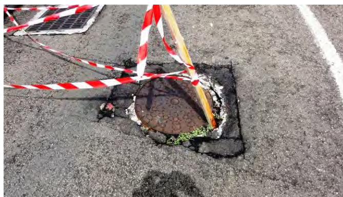
Photo 12: Exemple de tampon non conforme rue du collège
