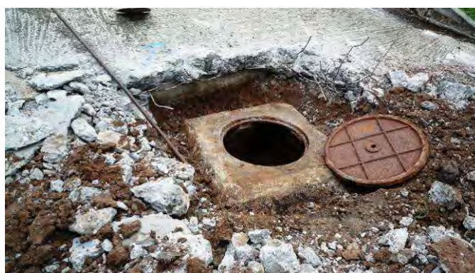
Photo 14: Regard recouvert sous chaussée
