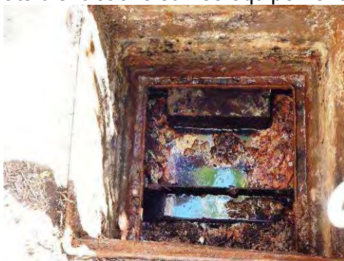
Photo 10 : Exemple de boîte à graisse d'un restaurateur
