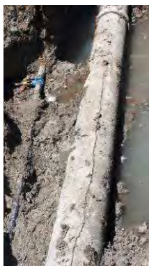
Photo 11 : Casse sur réseau gravitaire (rue des bougainvilliers)
