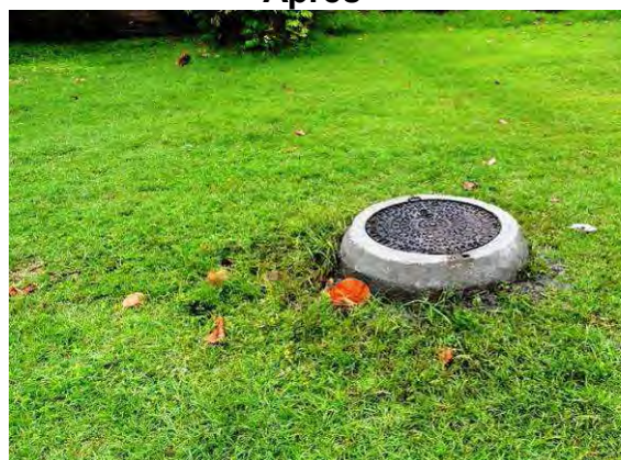
Tampons hydrauliques réseau du camping de la Pointe du Marin
