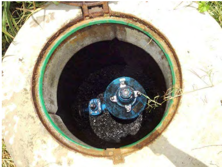
Photo 5 : Ventouse sur refoulement PR Bourg
