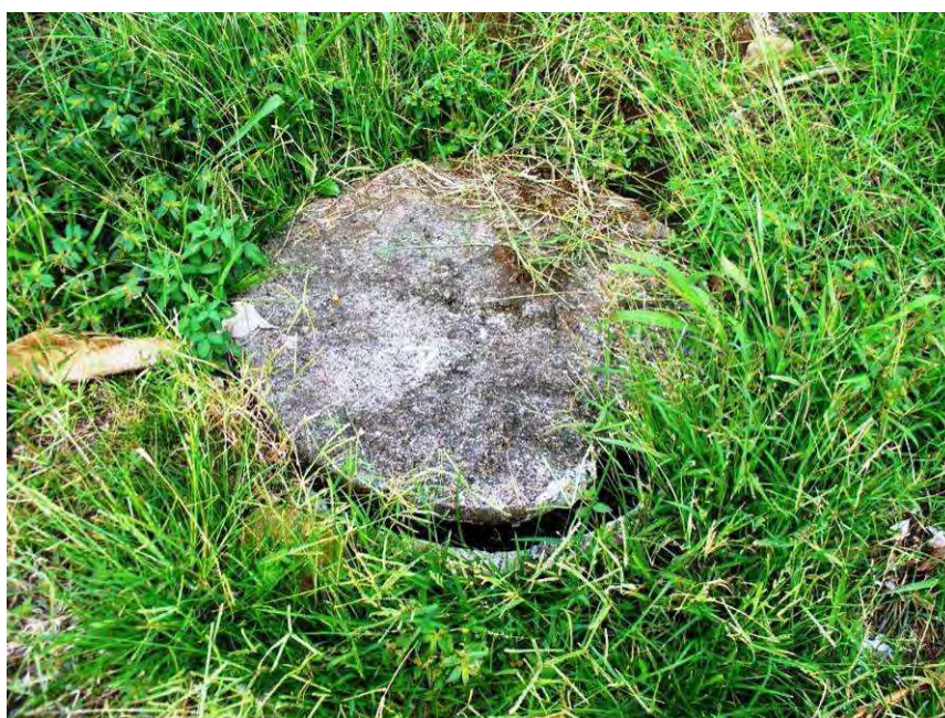
Photo 9 : Tampons réseau gravitaire en Camée
