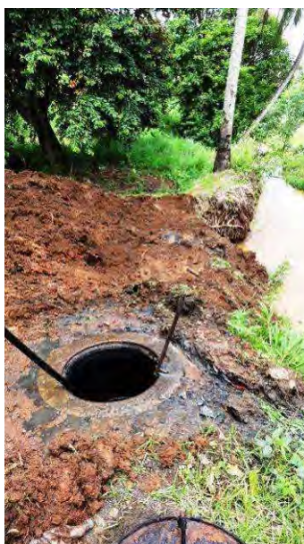
Photo 6: Exemple de regard inaccessible et en zone inondable
