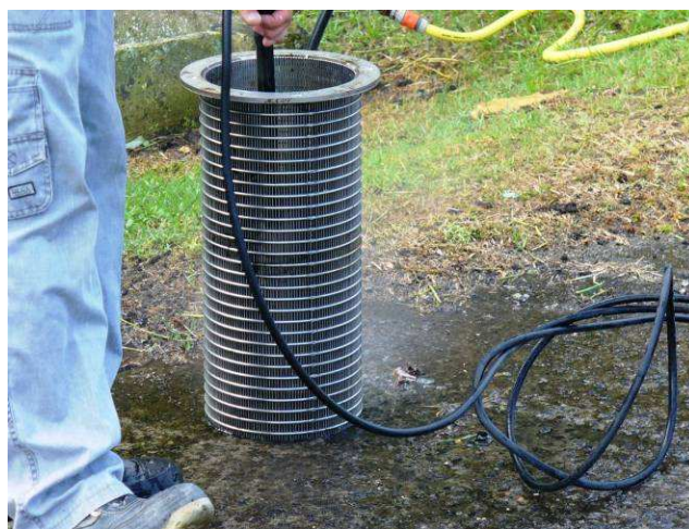
Photo 7 : Nettoyage HP à contre courant du dégrilleur
