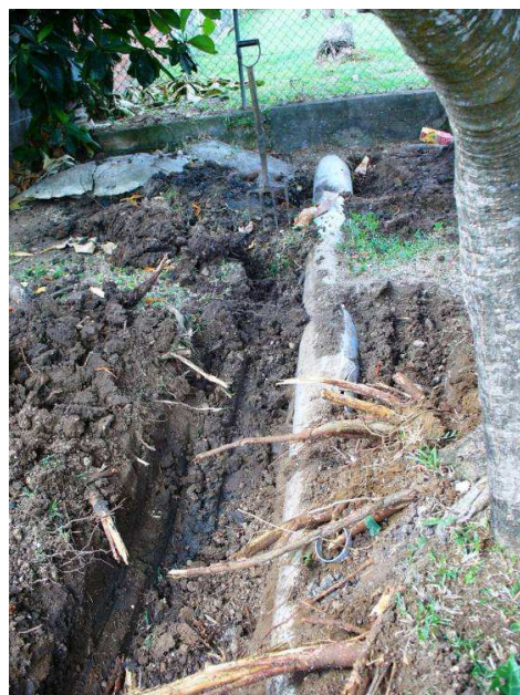
Photo 2 : Exemple de réseau posé sur le terrain naturel
