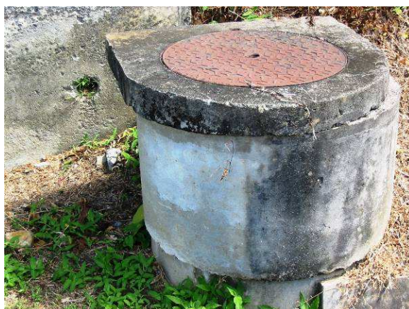
Photo 4 : Exemple de regards non conformes
