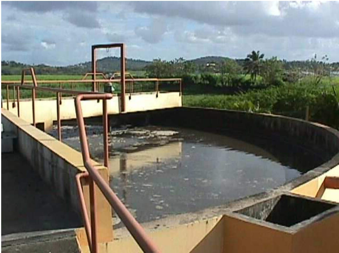
Station de traitement d'eaux usees du bourg. -Bassin d'aération -
