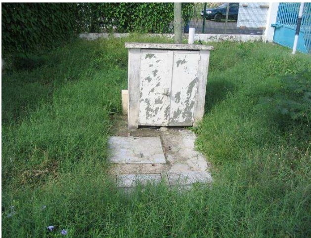
Photo 5 : Poste Cité Scolaire avant mise hors d'eau
