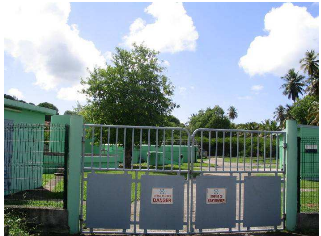
Photo 12 : Entrée PR Zone portuaire par ancienne Station du bourg
