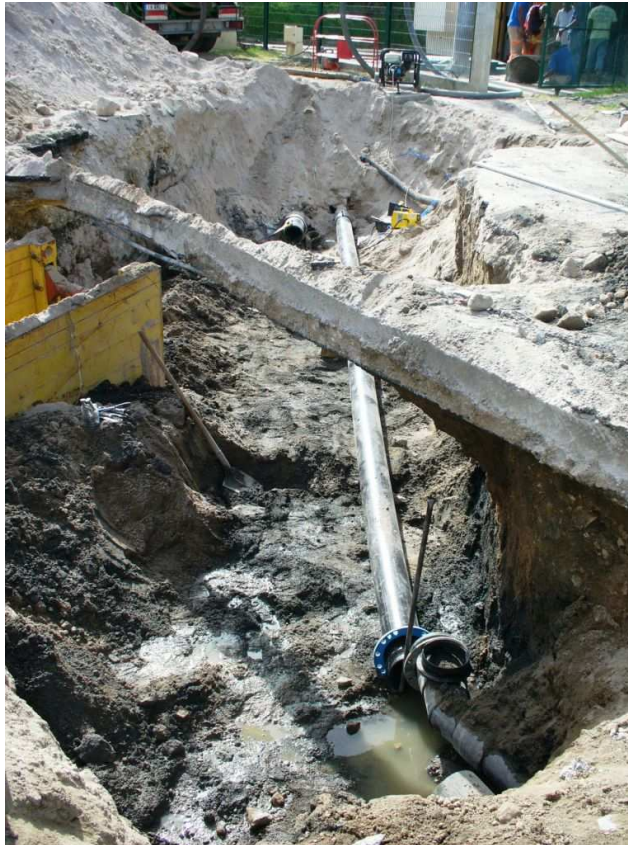
Photo 15 : Raccordement du nouveau Pr Bourg à la Station
