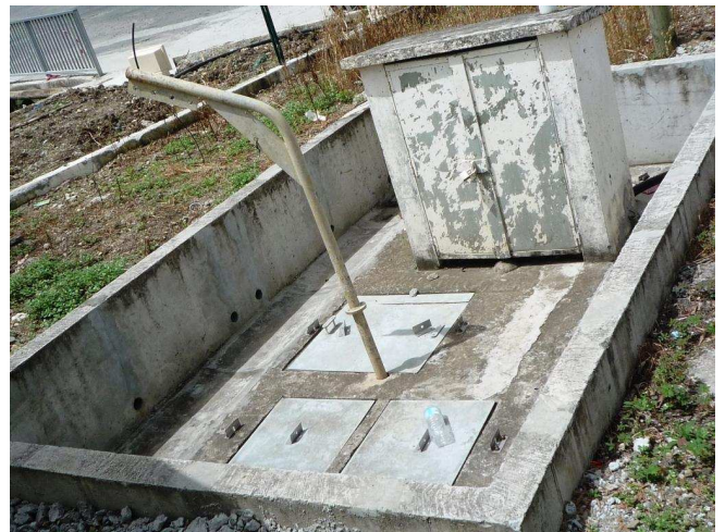
Photo 6 : Poste Cité Scolaire après mise hors d'eau
