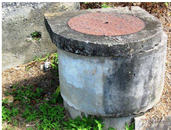
Photo 2 : Exemple de regards non conformes
