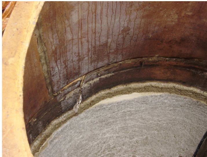
Photo 8 : Dégradation de la bache du PR Les Coteaux
