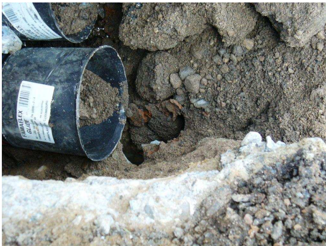
Photo 3: Effondrement du réseau amiante ciment
