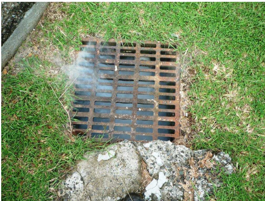
Photo 4 : Intrusion d'eaux parasites sur un regard d'eaux pluviales (bassin versant de pays noyé)
