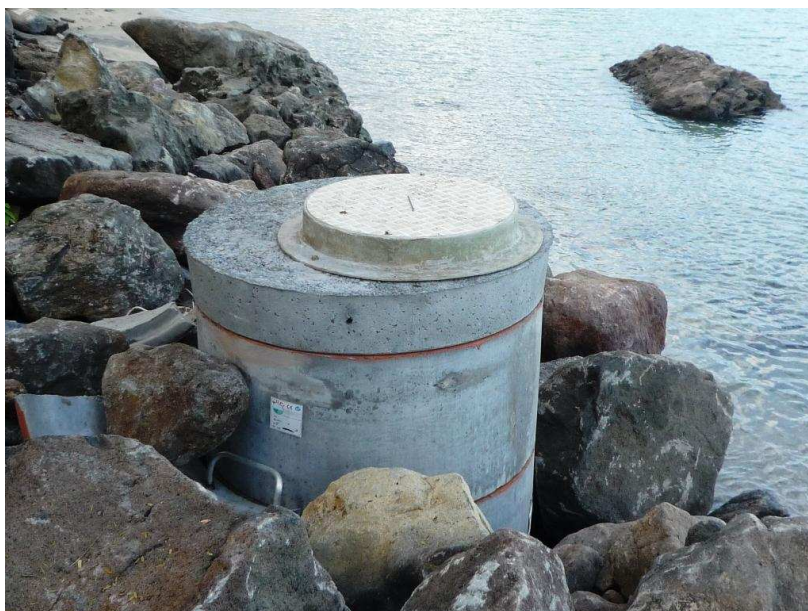
Photo 1: Exemple de reprise de regard NF 1000 - réseau Grand Anse
