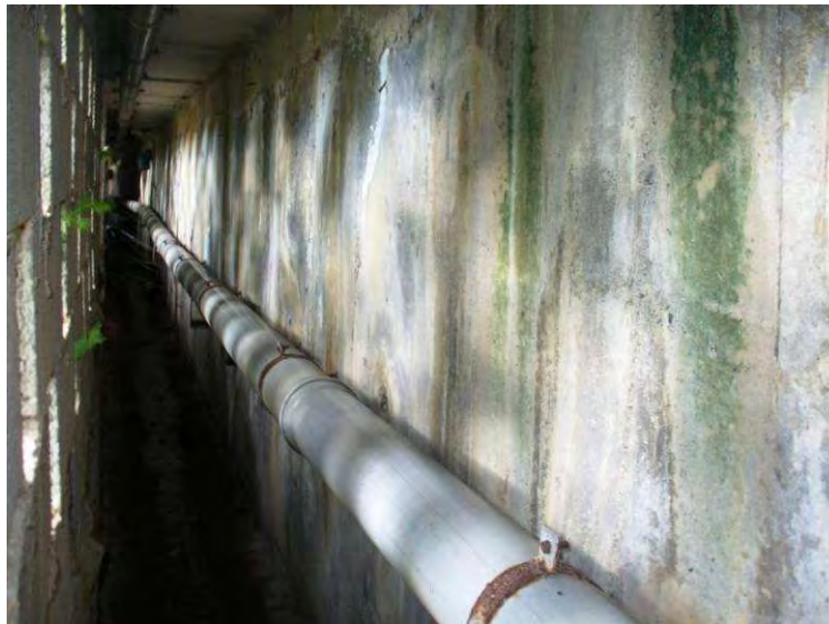
Photo 11 : Galerie de passage des eaux usées, pluviales et eau potable
