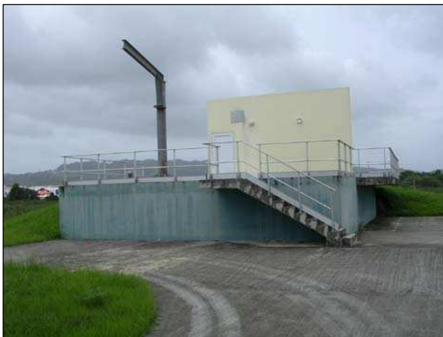
Poste de refoulement Petit Manoir
