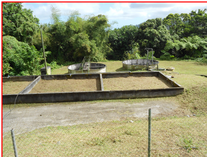
Station d'épuration de 500 eq.h
