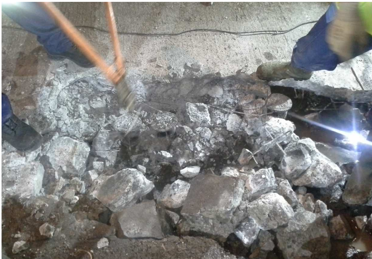
Mise à nu de plusieurs vannes, jusqu'alors inaccessible
