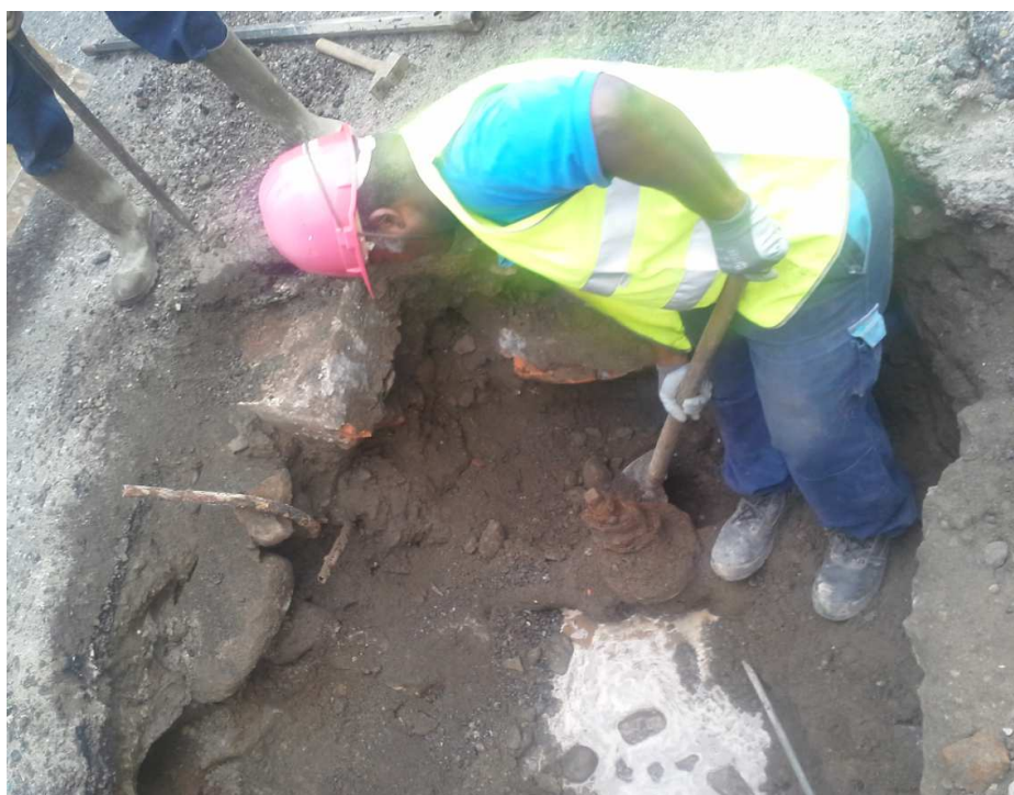
Dégagement d'une vanne existante
