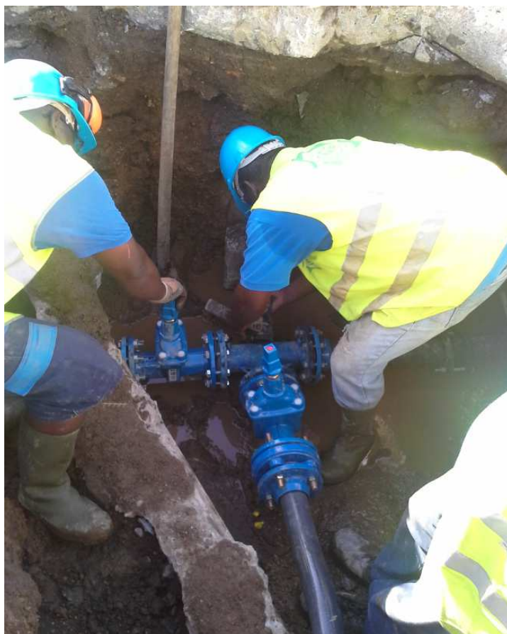
Mise en place de vannes neuves
