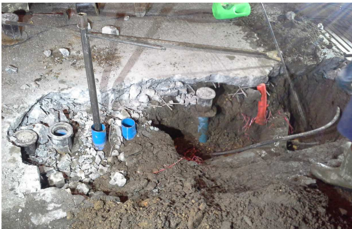
Tests de fonctionnement avant remise à niveau
