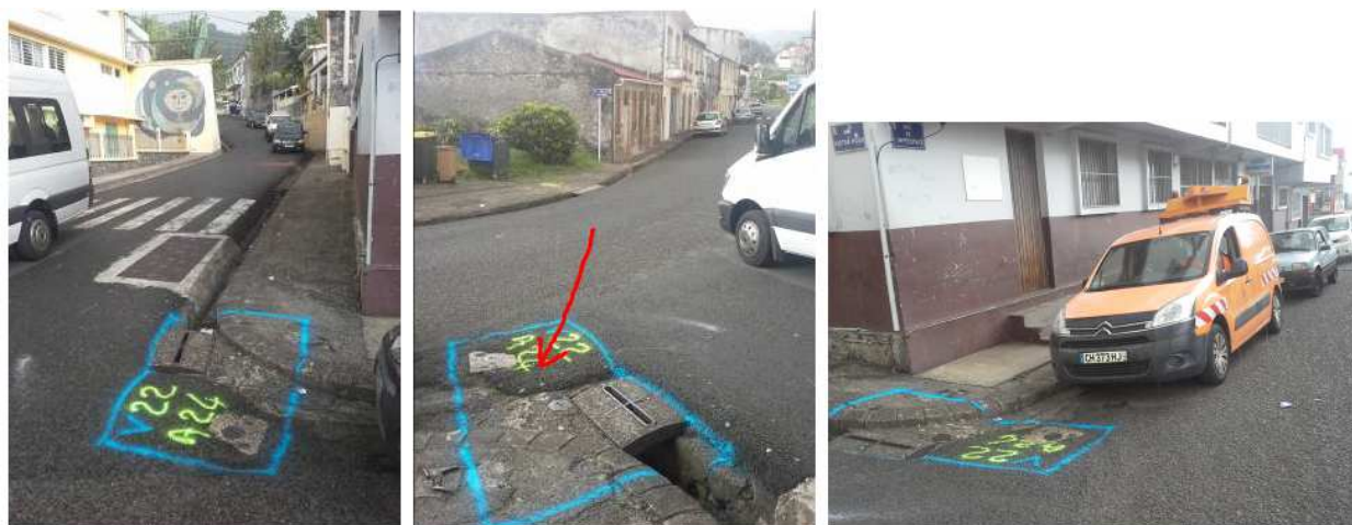
Localisation présumée de 3 vannes à l'angle des rues Victor Hugo et rue de l'Impératrice Les vannes sont peut-être sous la chaussée ou sous le trottoir. Impossible d'être plus précis sans avoir ouvert la chaussée.
