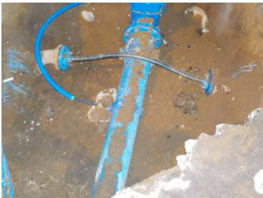
Renouvellement de branchement
