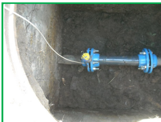
Mise en place des loggers acoustiques
